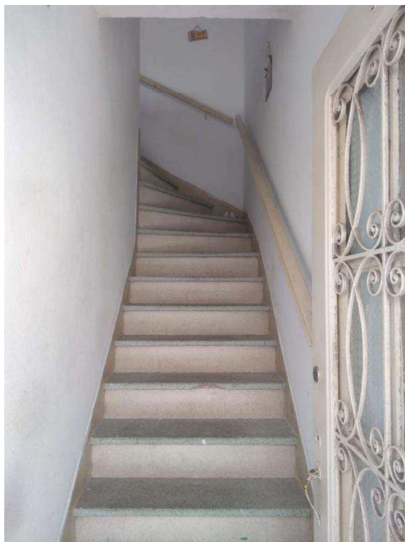
FOTO Nº 5 - Vista da escada de acesso ao apartamento 5.
