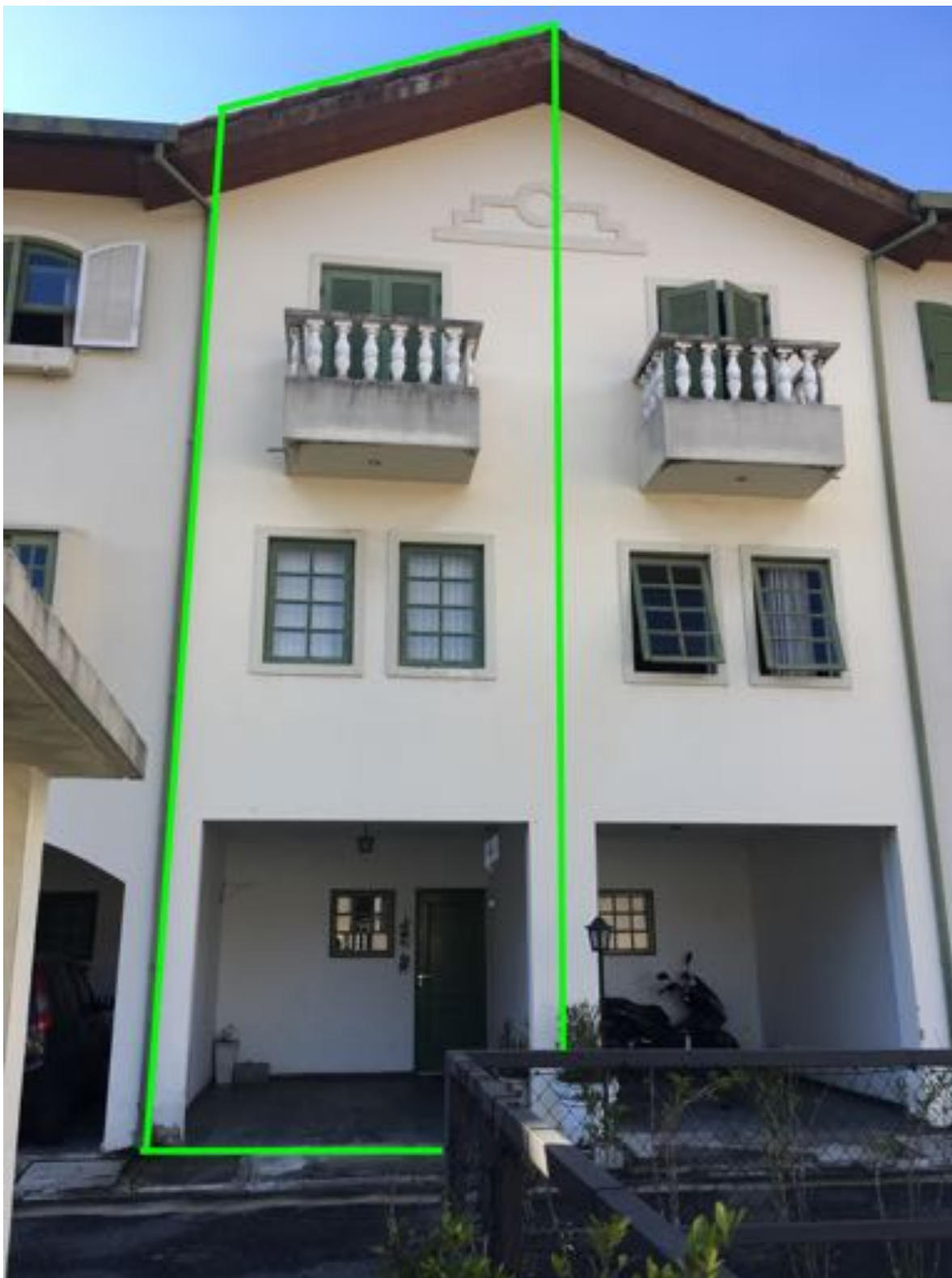
Foto 2: destacado, em linhas verde limão o imóvel avaliando, constituído por edificação em 3 níveis: garagem e lavabo no piso térreo; sala e cozinha no piso intermediário; e dois quartos e um banheiro no segundo andar.
