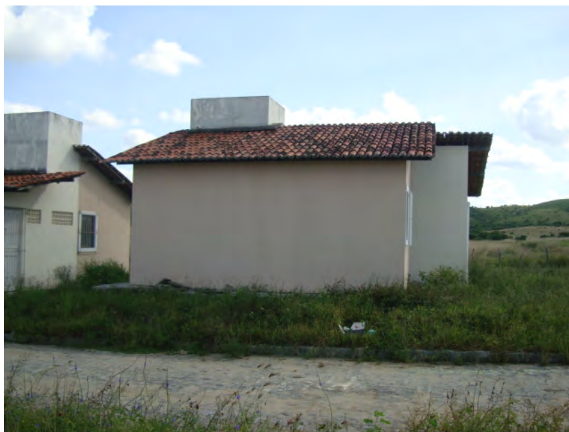
Detalhe da lateral da casa 1 Quadra J
