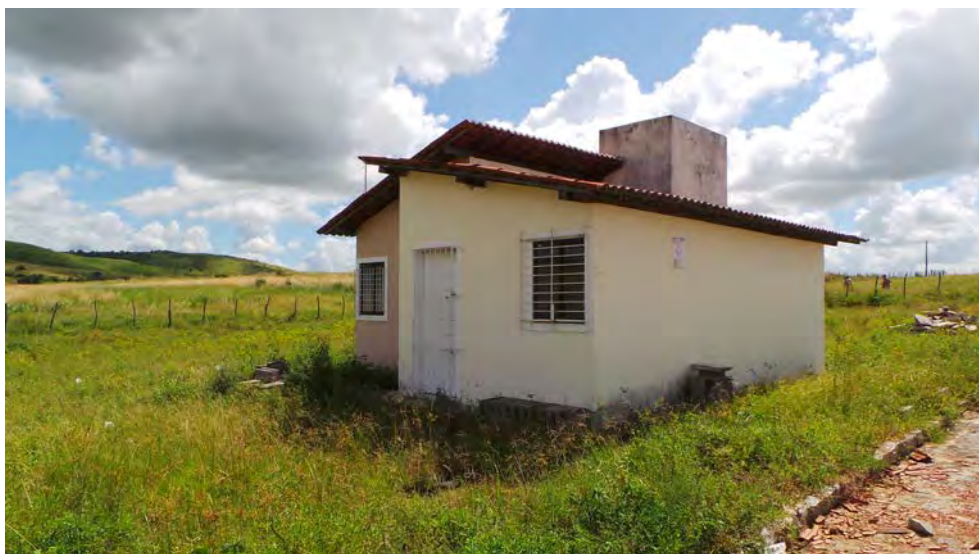
Detalhe da frente da casa 13 Quadra J
