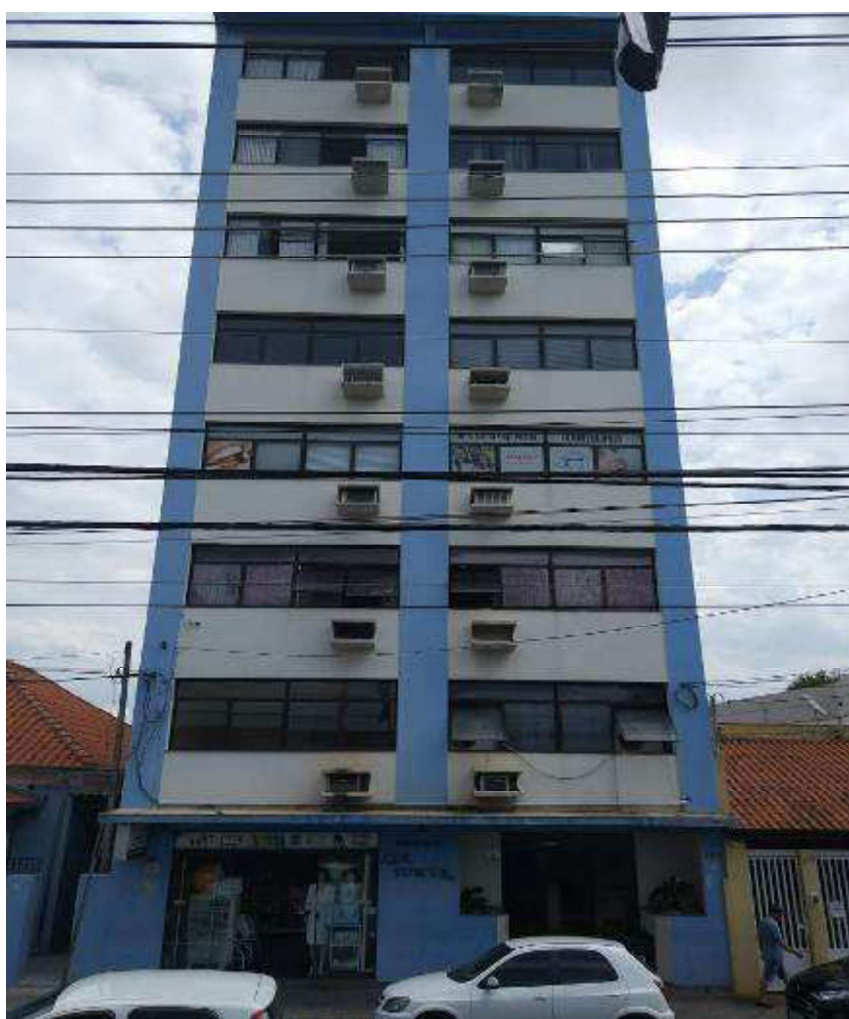
Foto 1: Prédio aonde situa-se o imóvel da Avenida Barão de Itapema, 120, sala 33.
