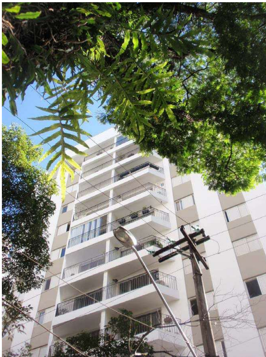
FOTO 7: FACHADA DO EDIFÍCIO.
