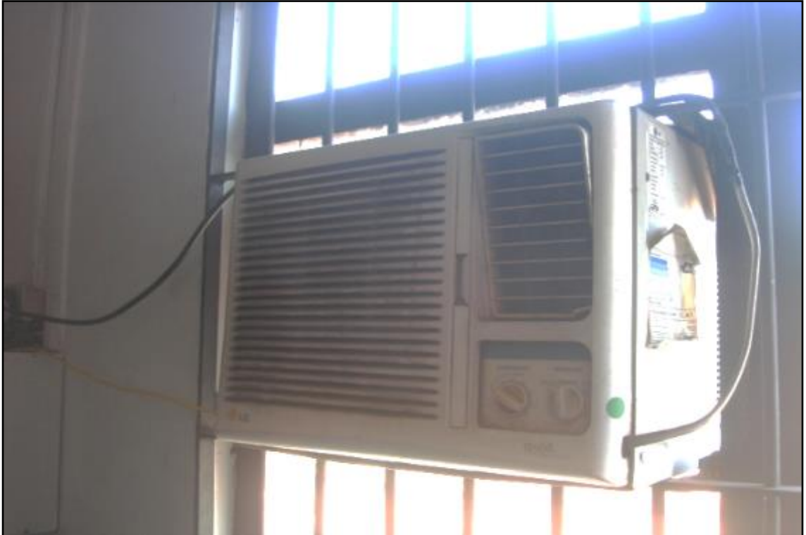
ITEM 2,102 - VISTA DO AR CONDICIONADO 7500 BTUS MARCA: LG MODELO: GOLD PROTECT WGM07 3FGA
