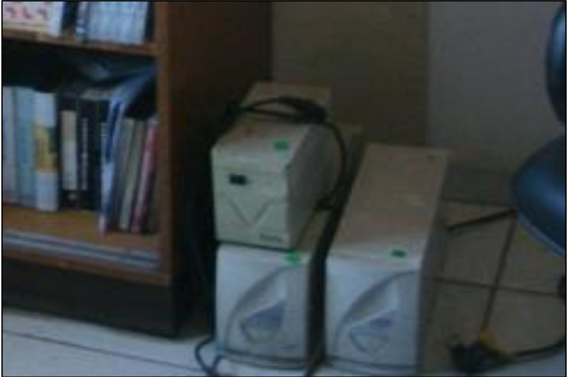
ITEM 3,003 - VISTA DO ESTABILIZADOR
