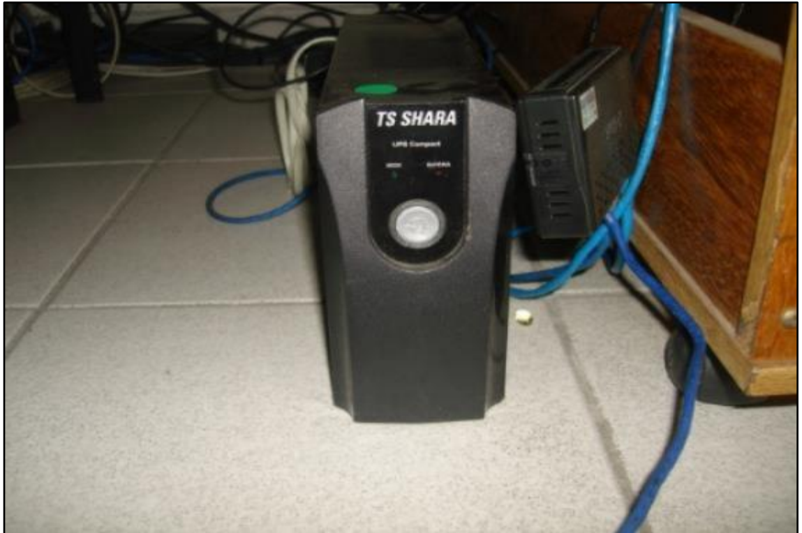
ITEM 3,026 - VISTA DO ESTABILIZADOR
