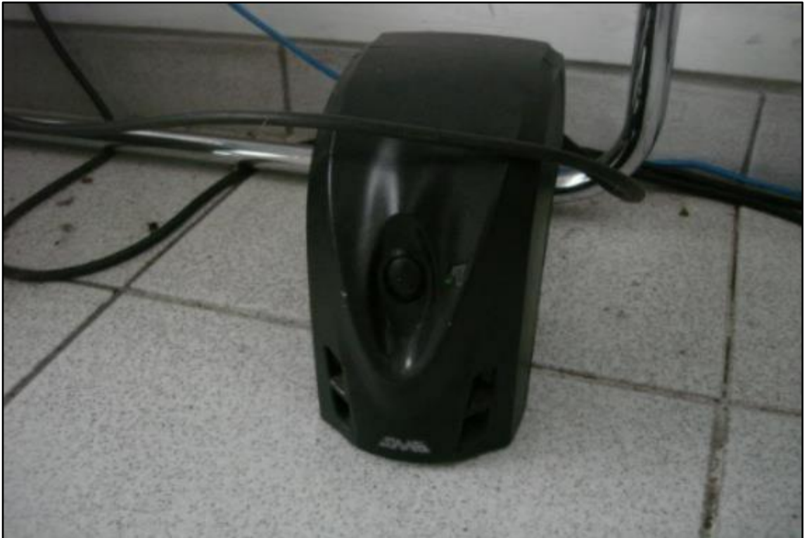
ITEM 3,051 - VISTA DO ESTABILIZADOR
