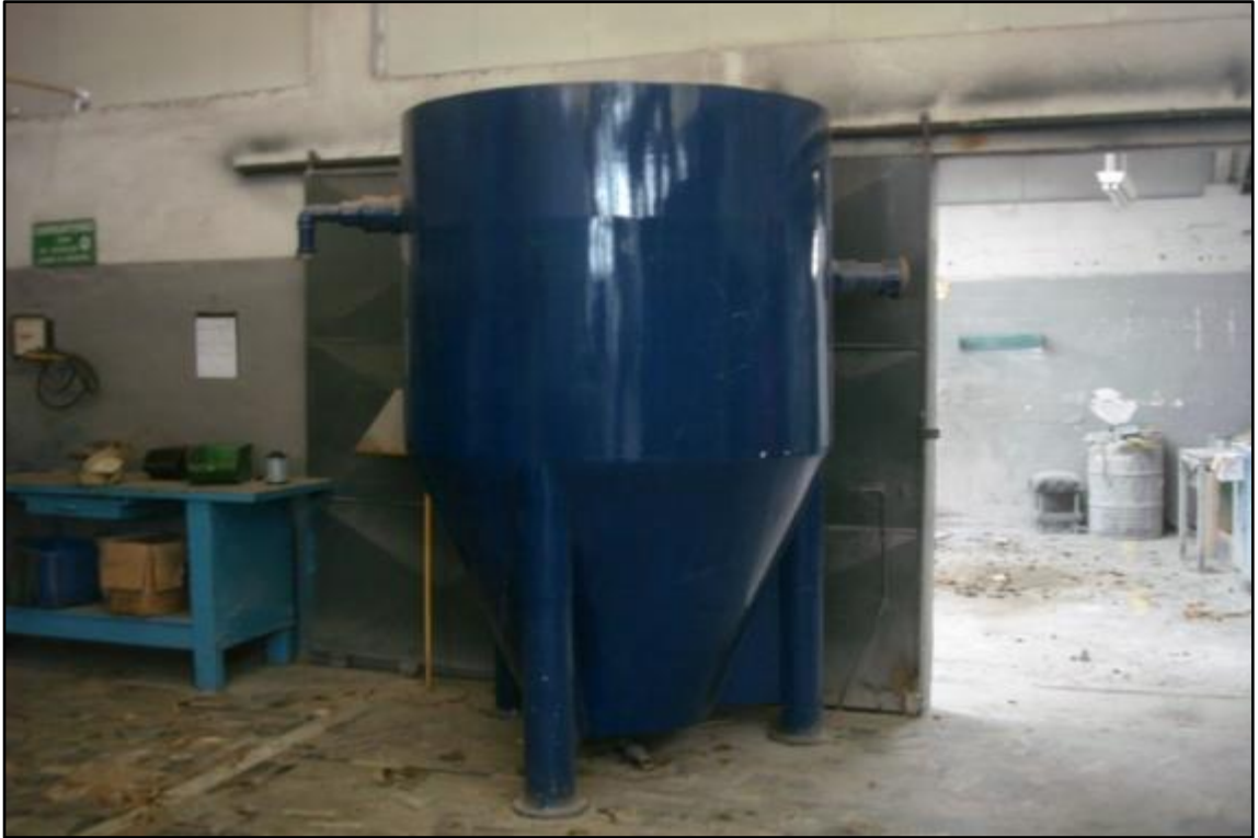
ITEM 5,357 - VISTA DO TANQUE INACABADO APROXIMADAMENTE 3000L
