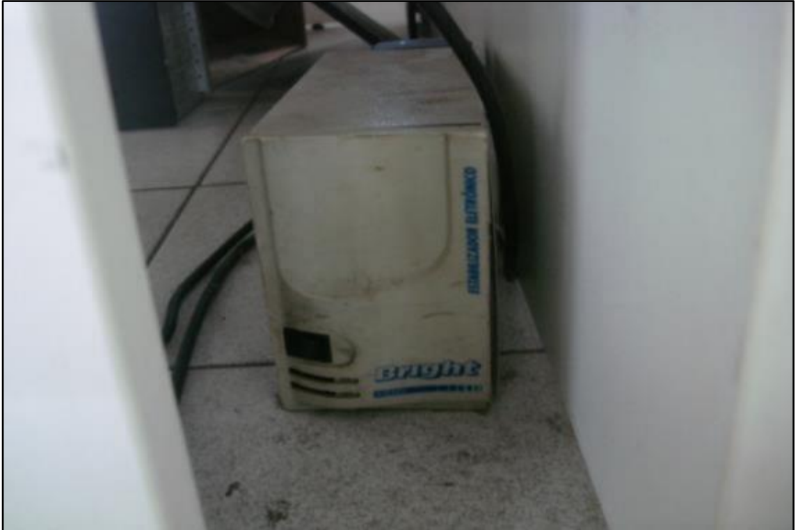
ITEM 3,017 - VISTA DO ESTABILIZADOR
