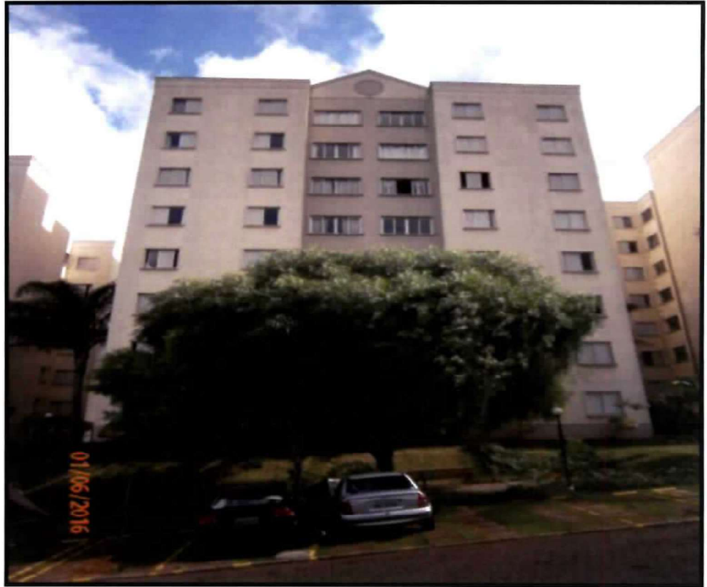
FOTO Nr.03: Vista da fachada do bloco B voltada para a via de circulação interior do Residencial.
