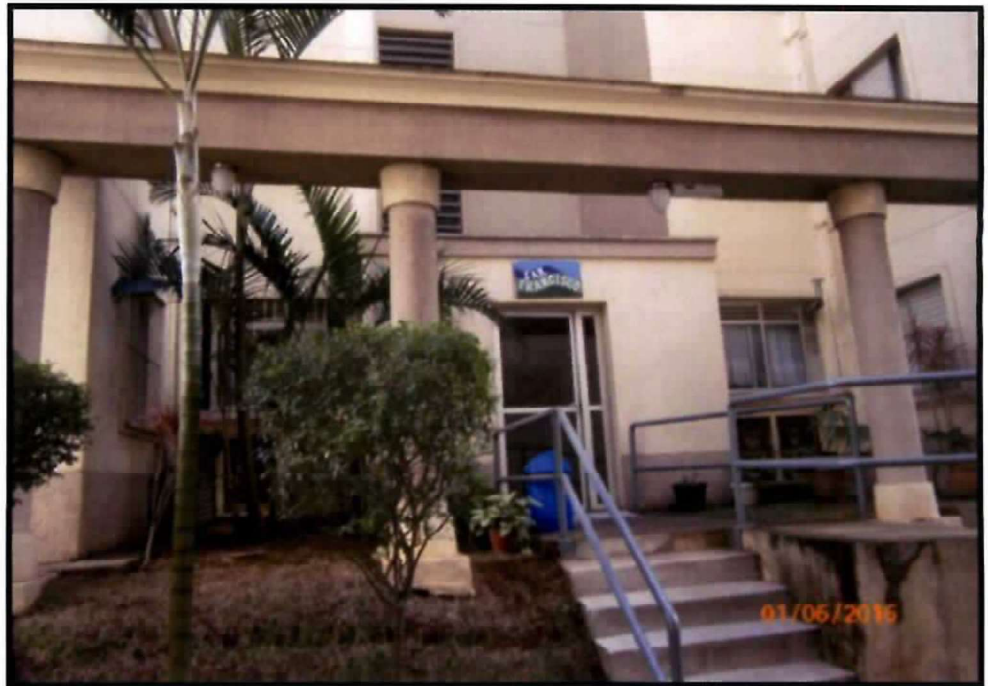
FOTO Nr.04: Detalhe da entrada do Bloco B ou Edifício San Francisco.
