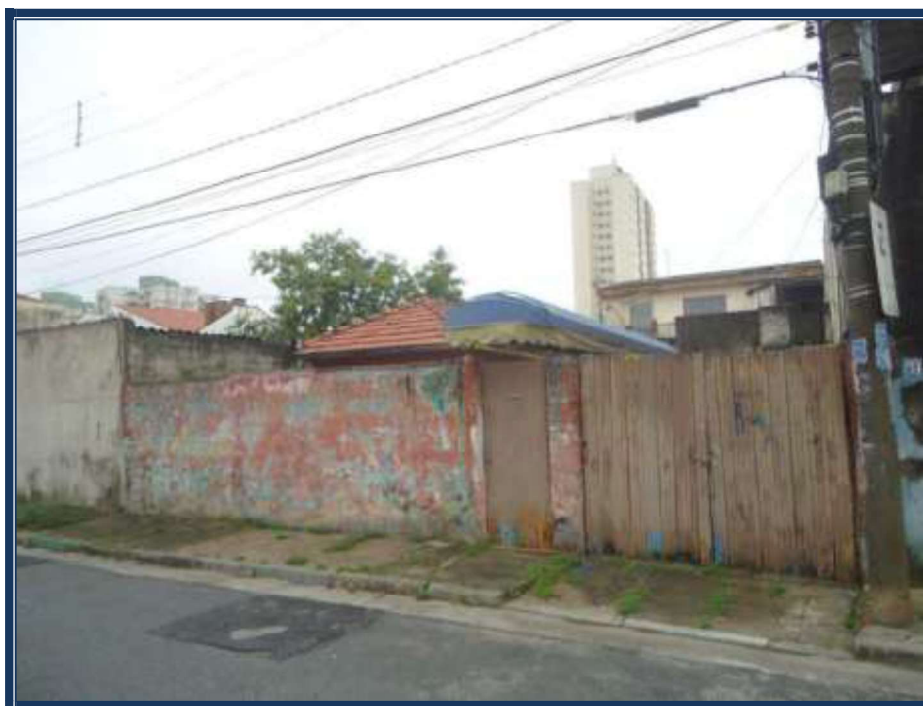
Vista da frente do imóvel avaliando.
