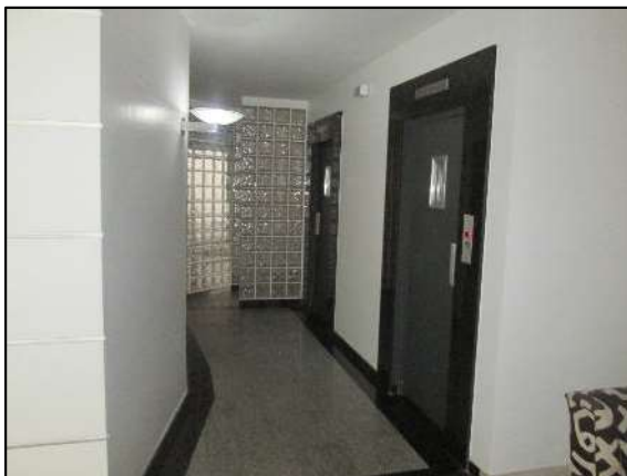
Acesso aos elevadores no hall, situado no pav. térreo
