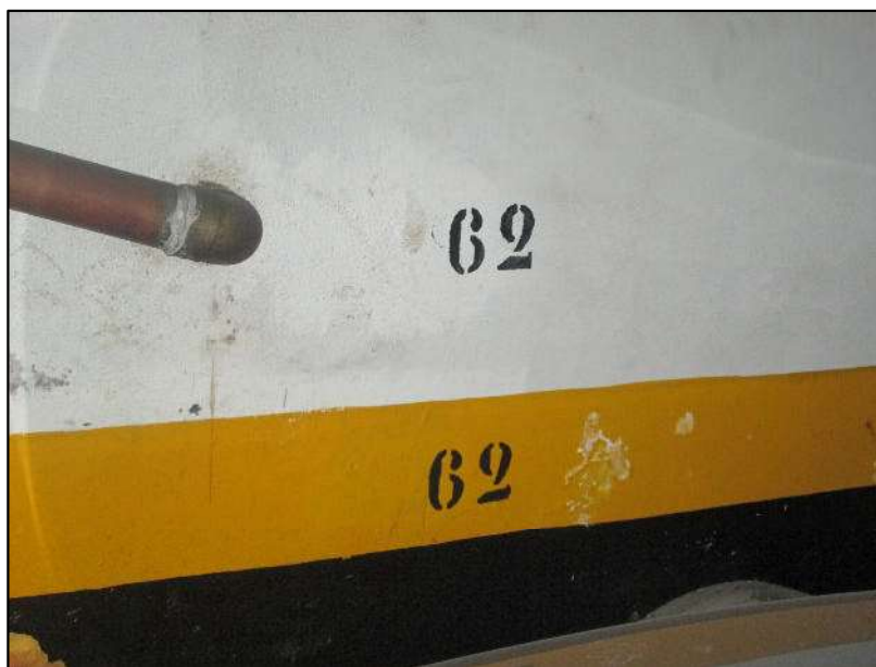
Vaga de garagem do imóvel avaliando
