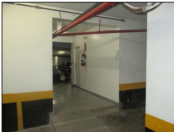
Acesso aos elevadores, situado no pavimento inferior
