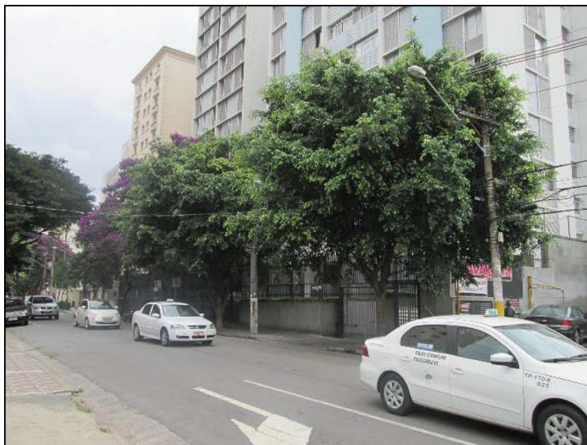
Vista do trecho da Rua Caconde em que se localiza o imóvel avaliando
