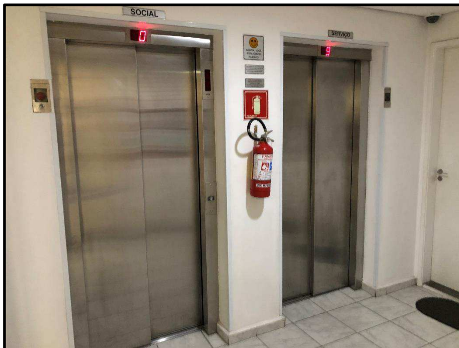
Foto 4 – Edifício Mar Báltico – Hall Elevadores
