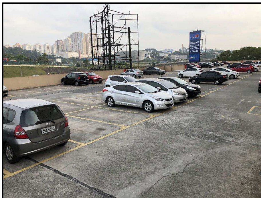
Foto 14 – Condomínio Residencial dos Mares – vagas de garagem
