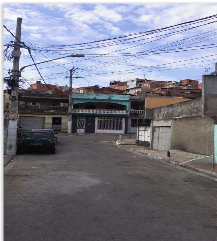
Foto 04 - Vista geral do entorno do imóvel.
