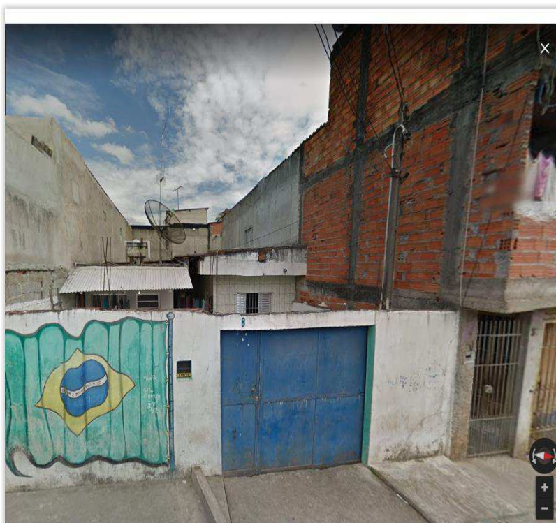
Foto 01 - Vista geral da fachada da casa erigida pelos Executados.
