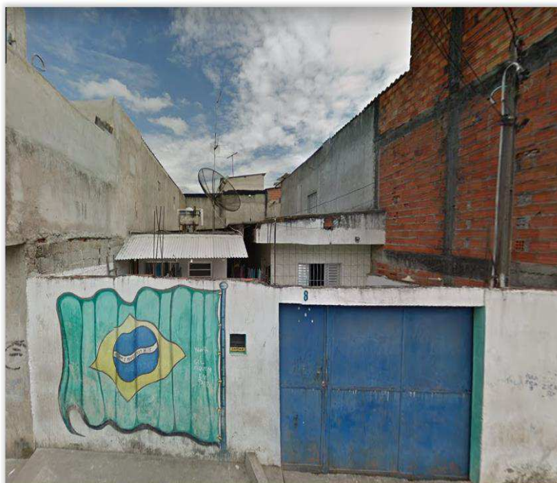
Foto 02 - Vista geral da fachada da casa erigida pelos Executados.
