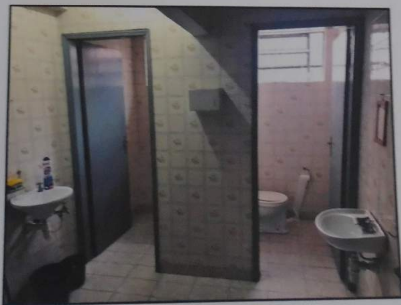
Foto 10 – "Edifício Carlos" – Sala Comercial – Salão – Banheiros
