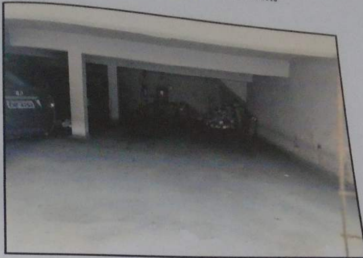
Foto 5 – Edifício Carlos – Vagas de Garagem – Vista 2
