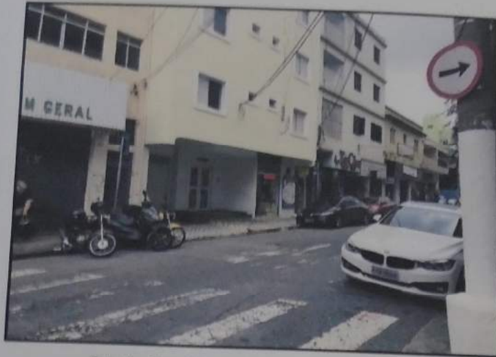
Foto 1 – Rua Helena Jacquey – Vista geral do acesso
