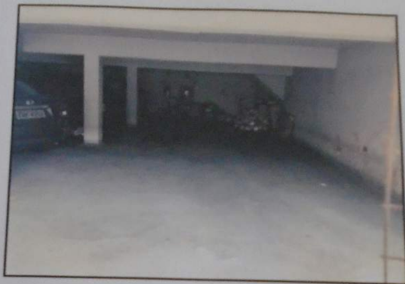
Foto 5 – Edifício Carlos – Vagas de Garagem – Vista 2
