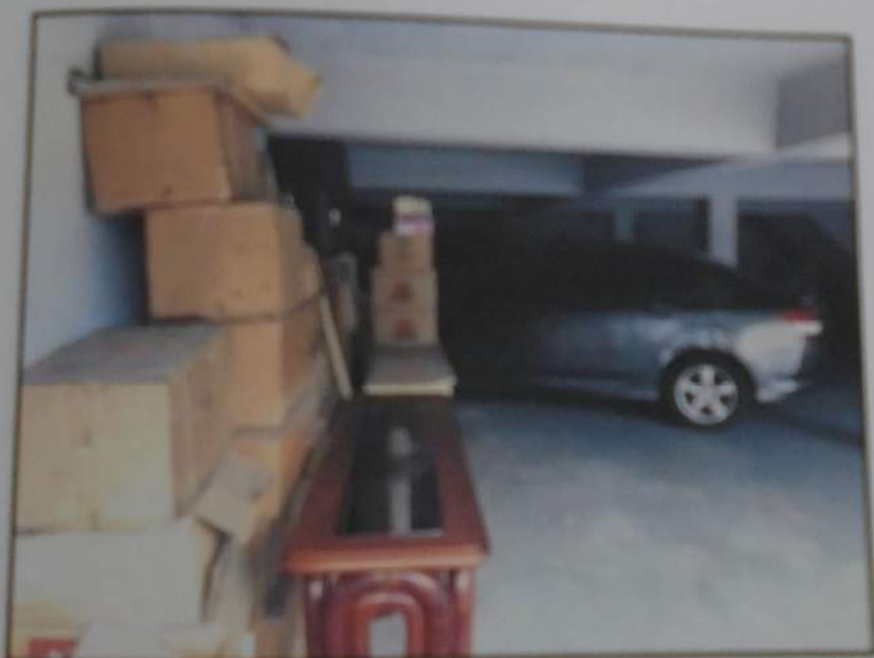
Foto 4 - Edifício Carlos - Vagas de Garagem - Vista 1
