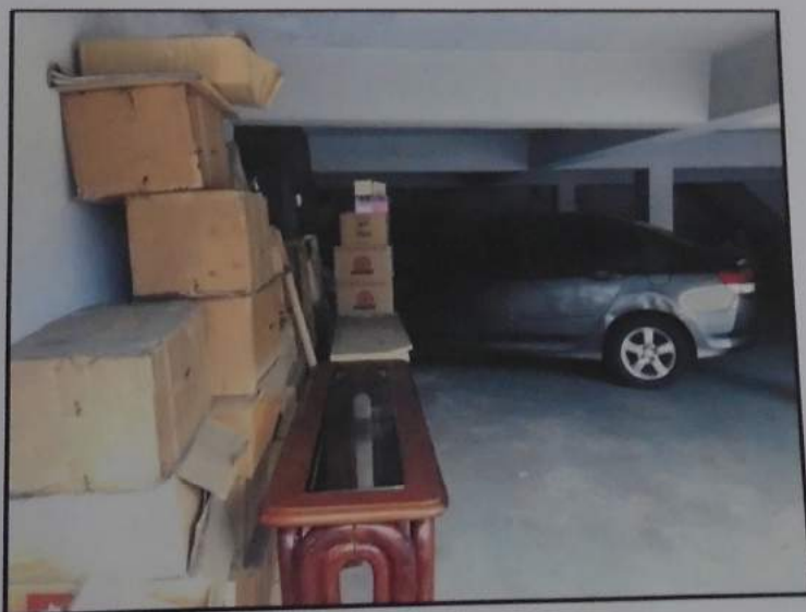
Foto 4 – Edifício Carlos – Vagas de Garagem – Vista 1
