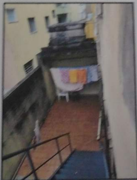
Foto 14 - "Edifício Carlos" - Sala Comercial - Salão - Área descoberta - Vista 1
