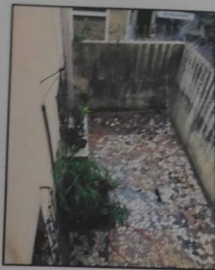
Foto 15 – “Edifício Carlos” – Sala Comercial – Salão – Área descoberta – Vista 2
