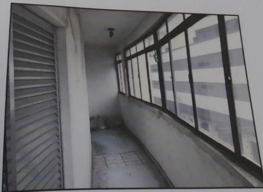
Foto 12 – “Edifício Carlos” – Apartamento 3 – Terraço – Vista 2
