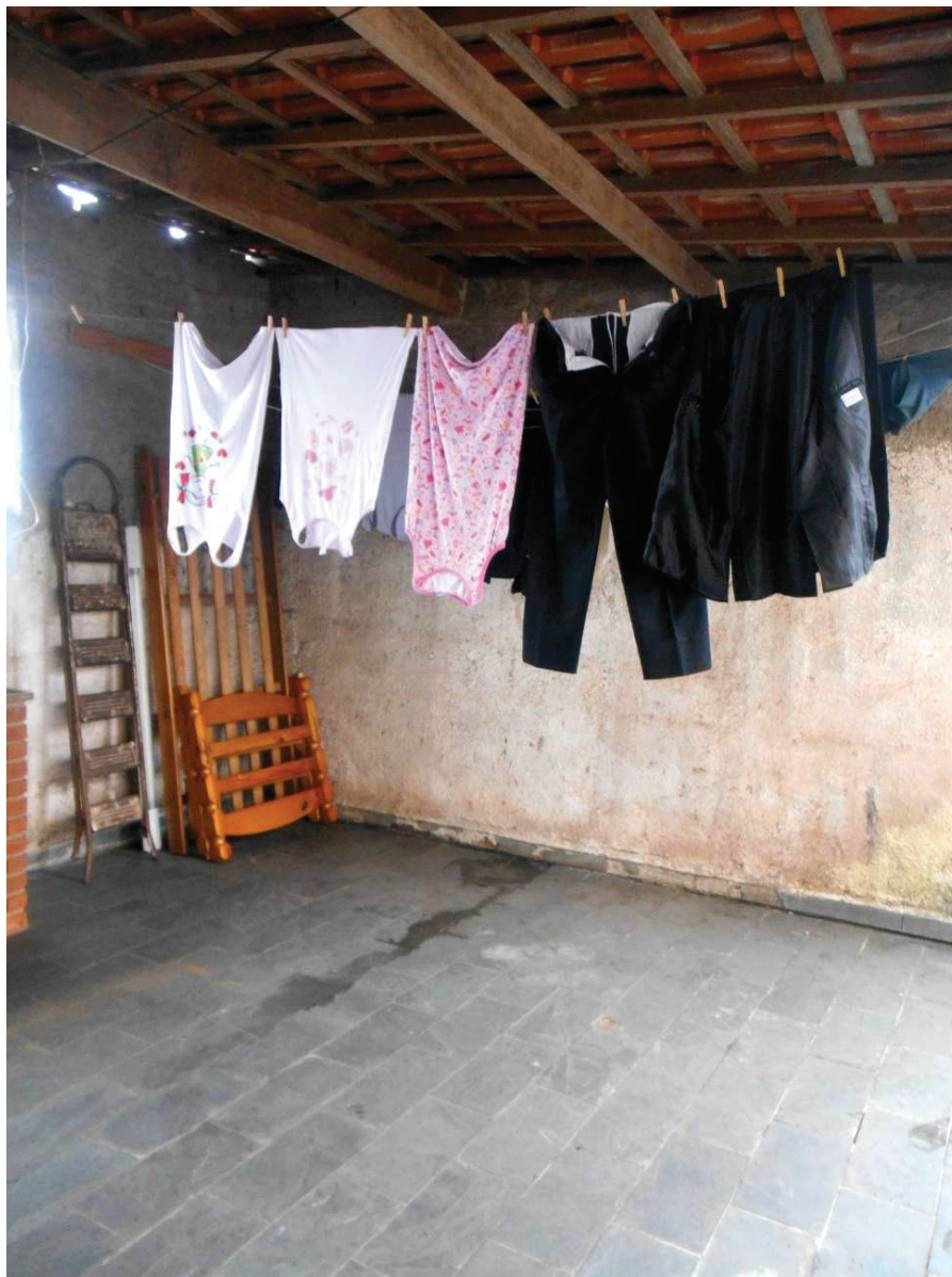
FOTO N. 15 : Telheiro situado no fundo do terreno, onde existe uma churrasqueira.
