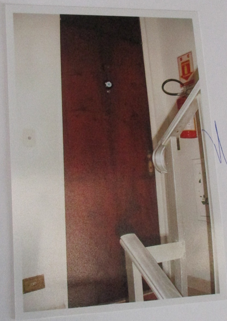
VISTA DA PORTA DE ENTRADA DO APARTAMENTO 22 DO EDIFÍCIO DRACENA II DO CONDOMÍNIO MONTE VERDE, ORA AVALIANDO.
