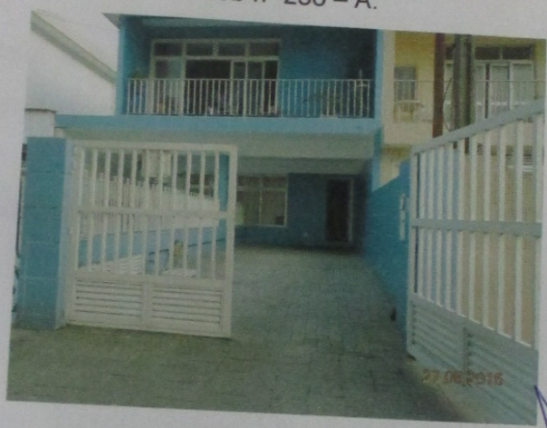
Vista frontal das sobrepostas, à direita o imóvel avaliando – pavimento superior, sob nº 236 – A.
