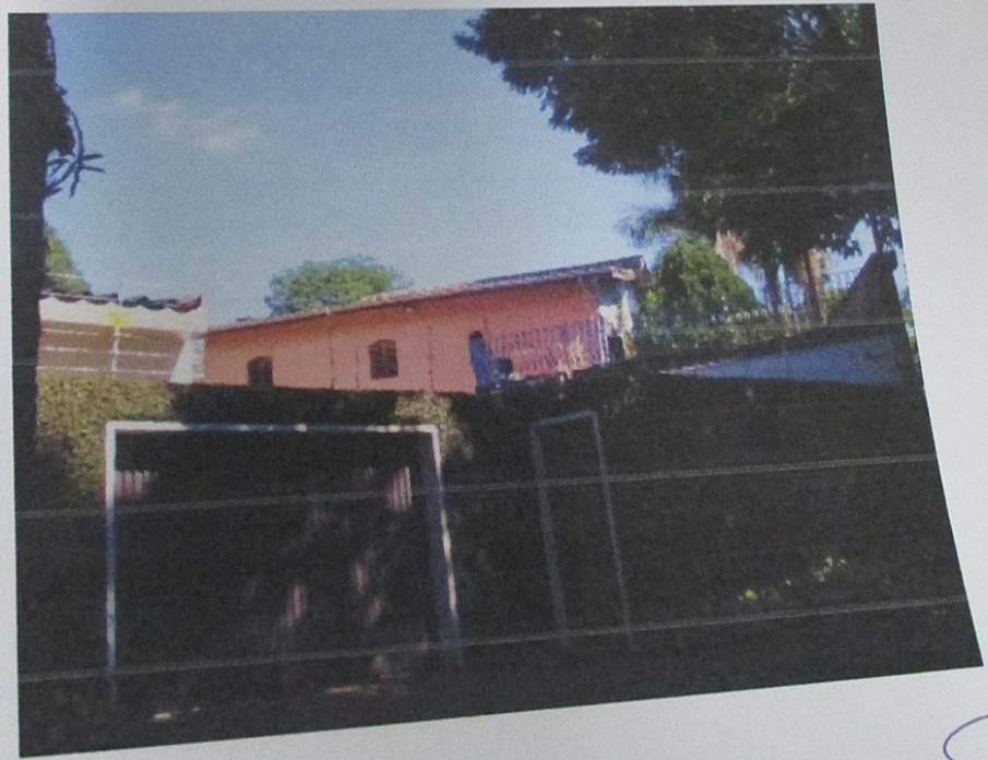
Todas as janelas do imóvel fechadas
