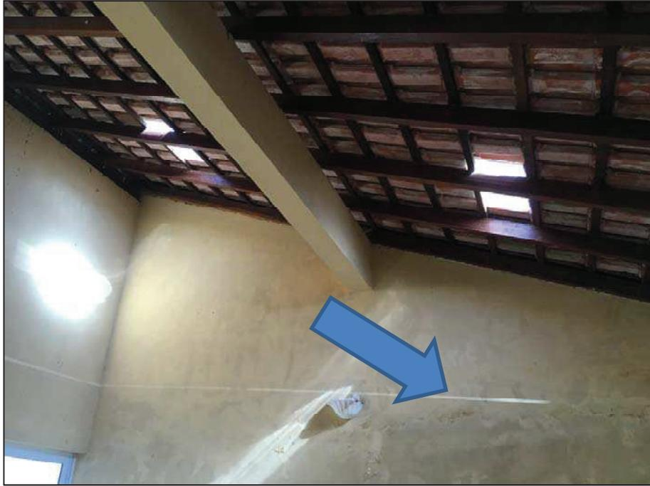
**Foto 03.** Detalhe da infiltração na garagem do imóvel avaliando.
