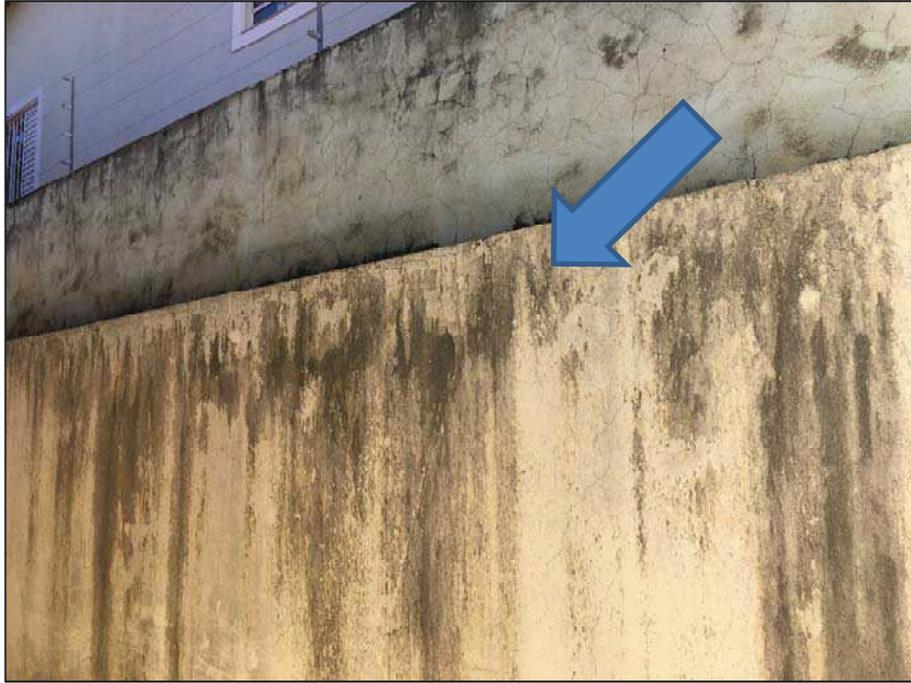
**Foto 41.** Detalhe da infiltração no muro do imóvel avaliando.
