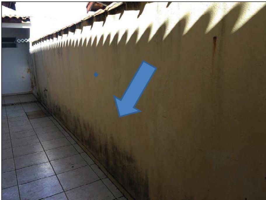
**Foto 34.** Detalhe da umidade no muro do corredor do imóvel avaliando.
