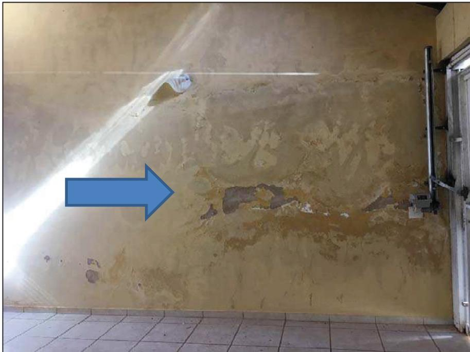
**Foto 04.** Detalhe da infiltração na garagem do imóvel avaliando.
