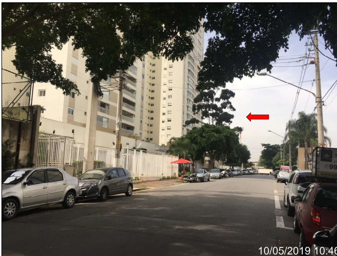
Foto 05: Vista do Condomínio Vila Nova Leopoldina I , da portaria localizada na Rua Nagel nº12 e do acesso e entorno.
