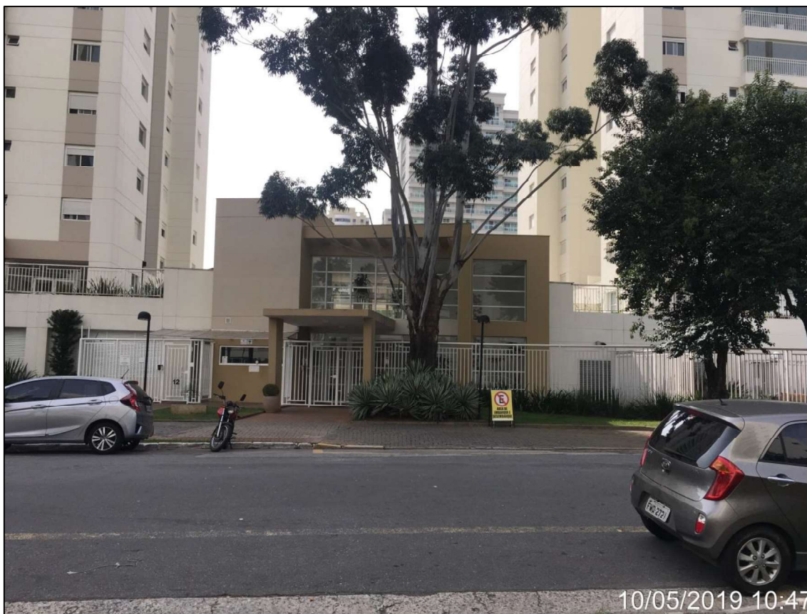
Foto 09: Vista da portaria do Condomínio Vila Nova Leopoldina I no acesso pela Rua Nagel nº12.
