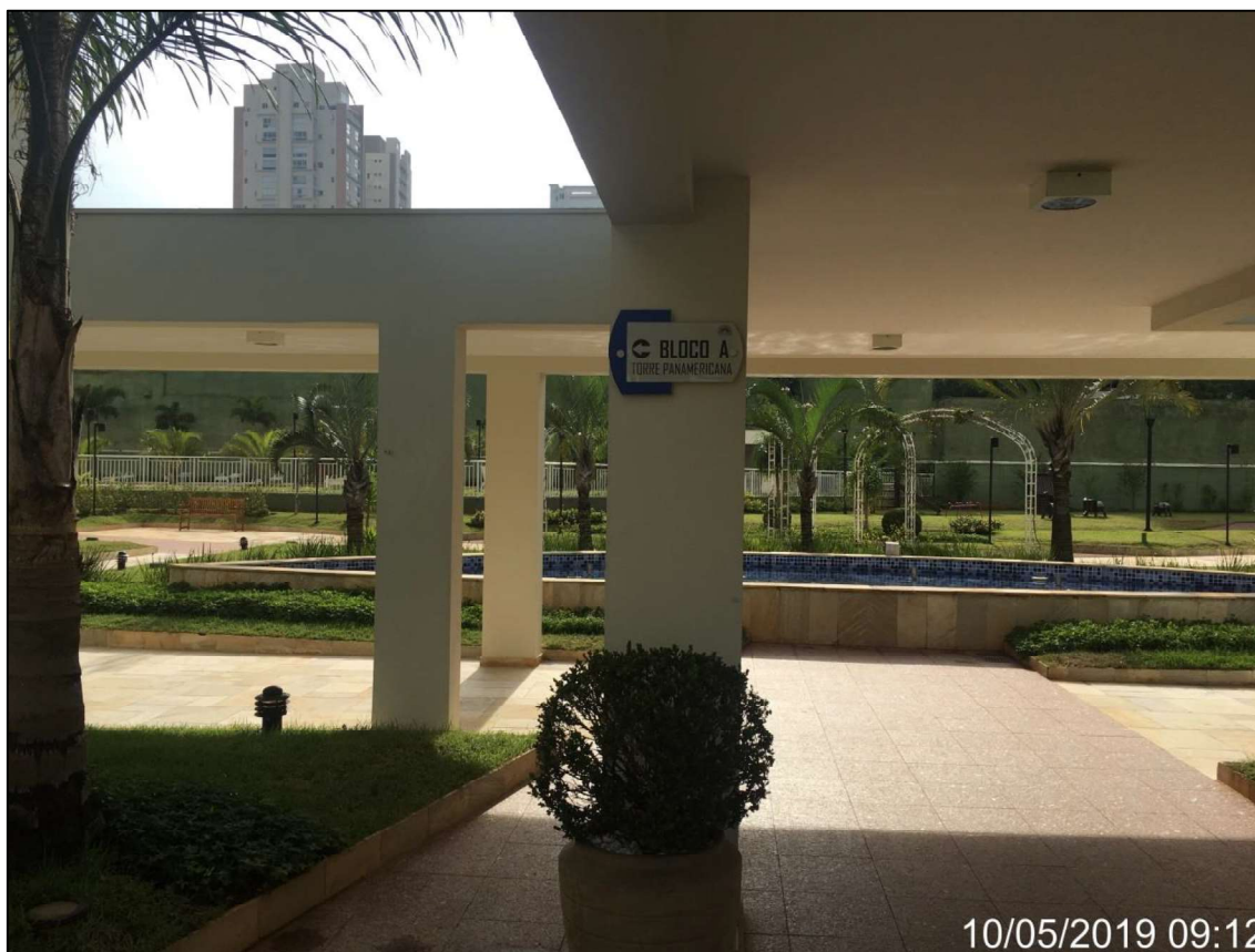
Foto 18: Outra vista da entrada social do Condomínio Vila Nova Leopoldina I.
