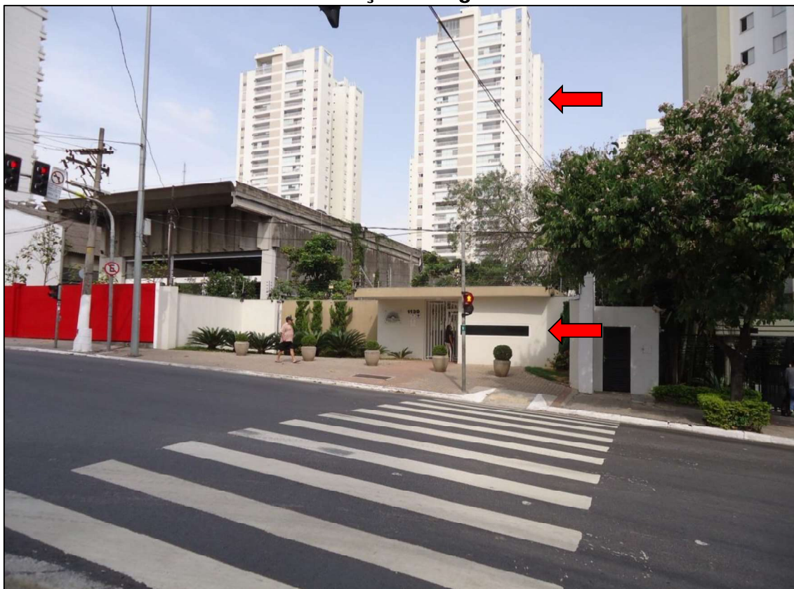
Foto 01: Vista frontal do Condomínio Vila Nova Leopoldina I localizado na Av. Imperatriz Leopoldina nº1.130 .
