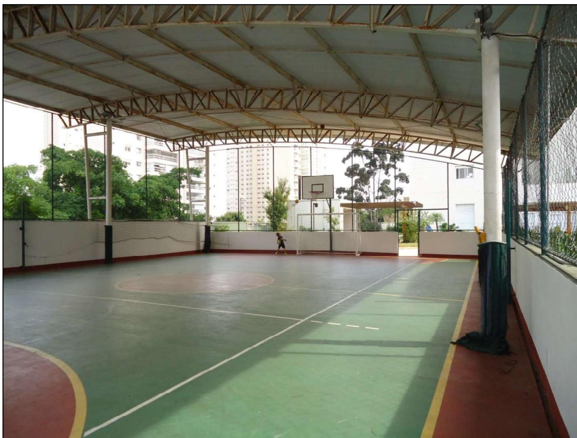
Foto 79: Outra vista interna da quadra poliesportiva coberta.
