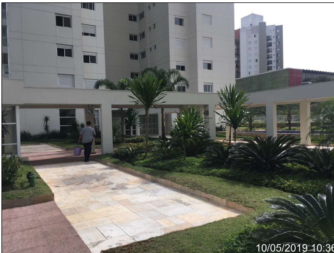
Foto 19: Vista dos acessos aos Edifícios 1 e 2 do Condomínio Vila Nova Leopoldina I.
