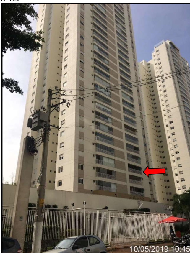
Foto 10: Vista do imóvel avaliando no 3º pavimento do Edifício 1 (Bloco A) (destacado).
