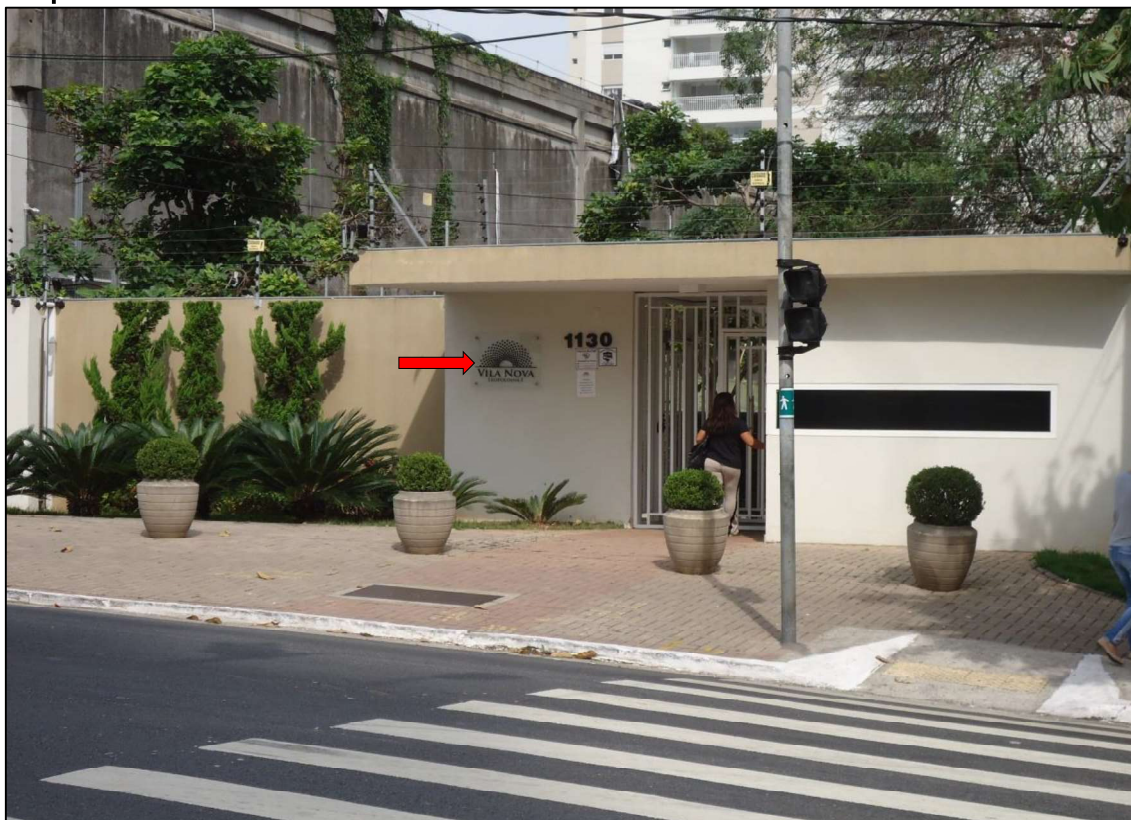
Foto 02: Identificação na portaria do Condomínio Vila Nova Leopoldina I localizado na Avenida Imperatriz Leopoldina nº1.130 .
