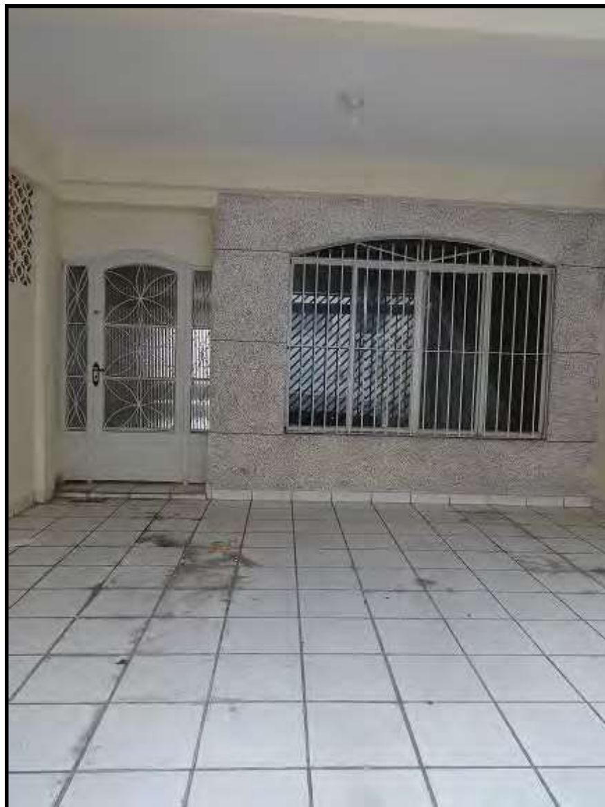
VISTA DA GARAGEM.
