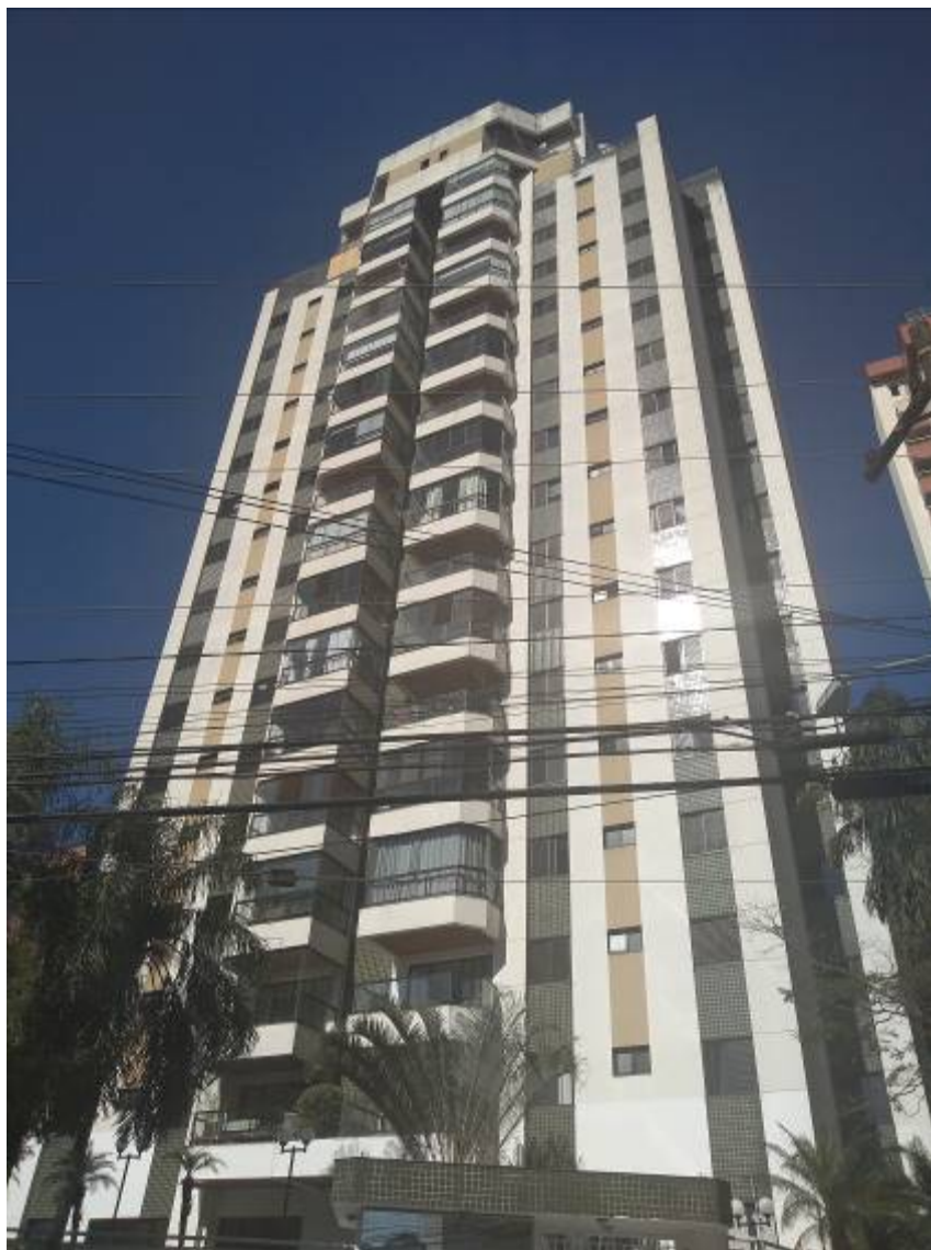
FOTO 4: FACHADA DO IMÓVEL.
