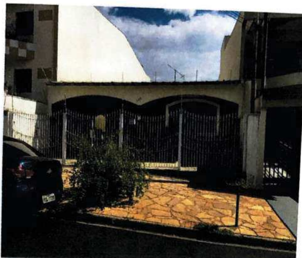
Foto 3 – Vista frontal do imóvel avaliando – Rua Batatais, 845
