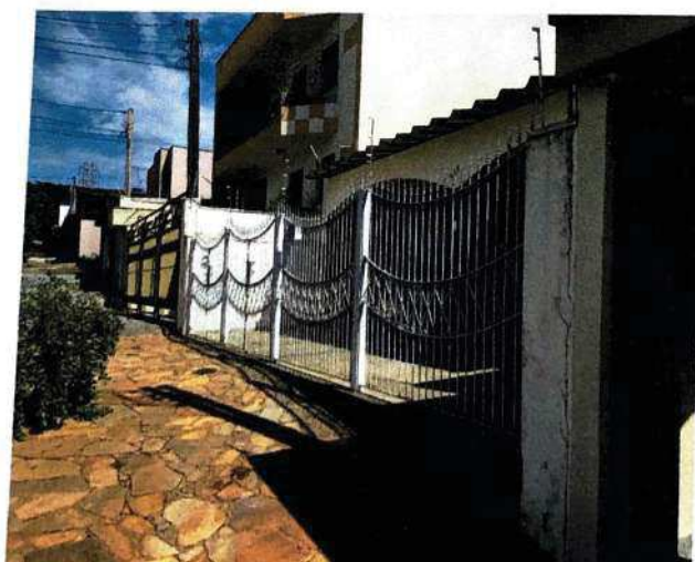
Foto 4 – Detalhe frontal do imóvel avaliando
