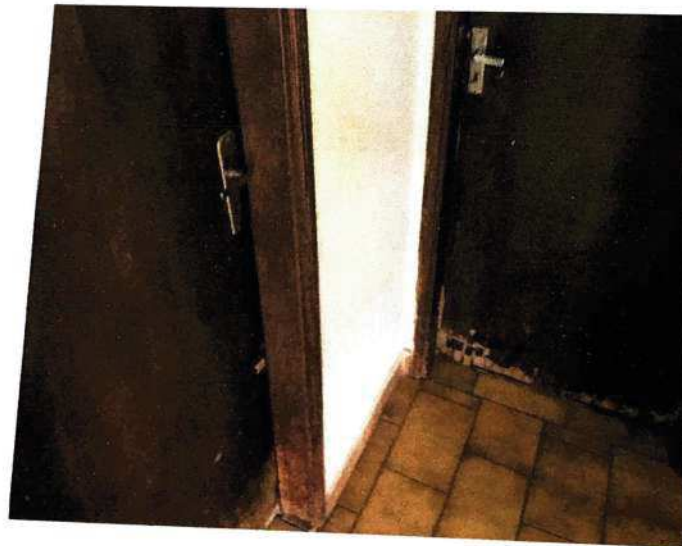
Foto 20 – Outro detalhe construtivo da edícula
