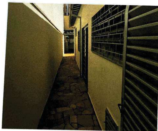
Foto 6 – Vista do corredor lateral
