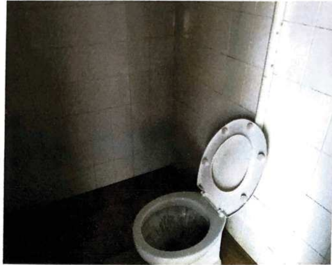
Foto 19 – Banheiro da edícula
