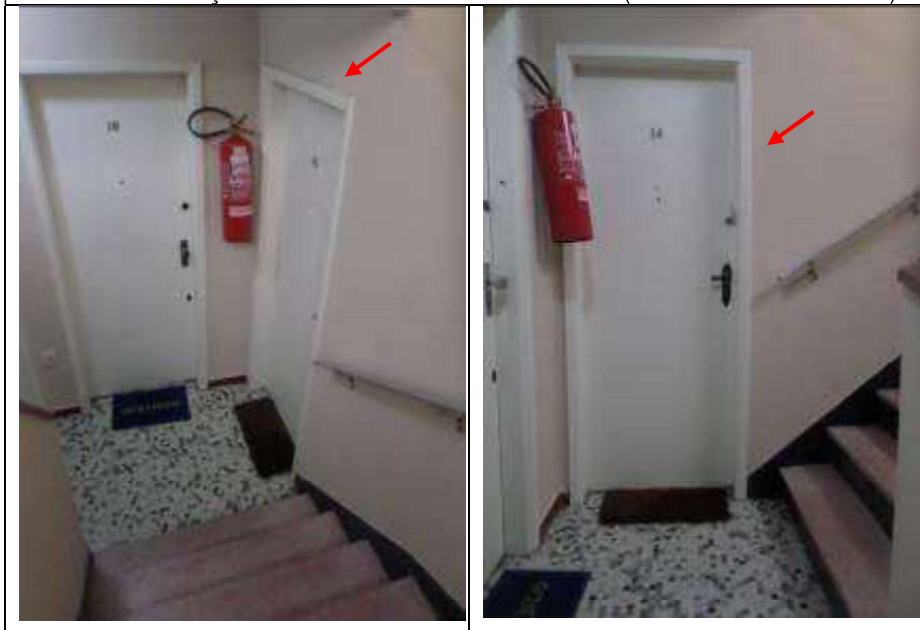
SÉRIE-FOTOGRAFICA 08 - REGISTRO DO HALL DE DISTRIBUIÇÃO COMUM NO SEGUNDO PAVIMENTO TIPO DO CONJUNTO RESIDENCIAL, COM A INDICAÇÃO DA PORTA DA UNIDADE 14 (IMÓVEL PENHORADO).
