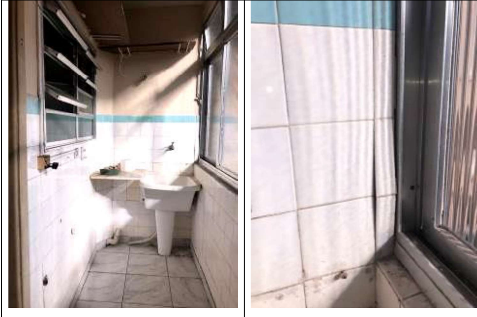
SÉRIE-FOTOGRAFICA 05 – DETALHES DA ÁREA DE SERVIÇO, COM BARRA DE AZULEJOS, POSSIVELMENTE ORIGINAL, NAS PAREDES, COM O REGISTRO DO ESTUFAMENTO LOCALIZADO DE PEÇA CERÂMICA.
