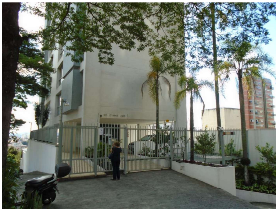
Foto nº. 4 – Vista da entrada do Edifício Cysne.
