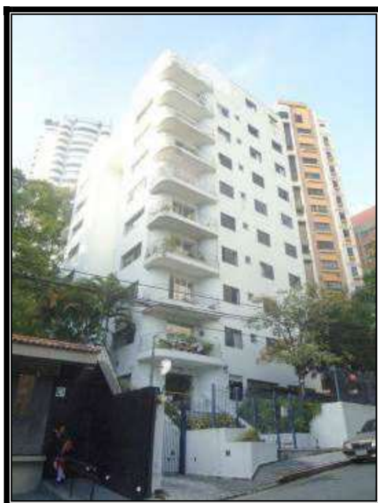
Vista da frente do Edifício Montgomery's Park.
