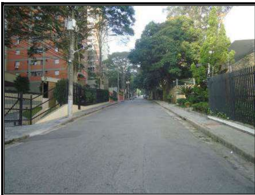
Vista da Rua Barão de Campos Gerais que dá acesso ao Edifício Montgomery's Park.
