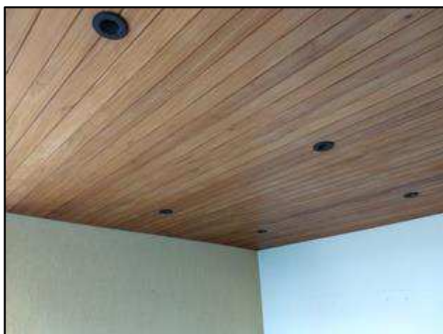
Foto 91 – Escritório 2 no 3º pavimento.
