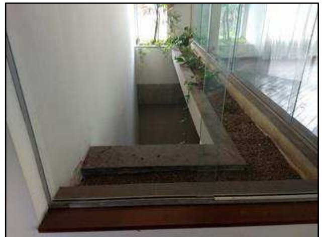
Foto 122 – Escritório 3 no 4º pavimento.
