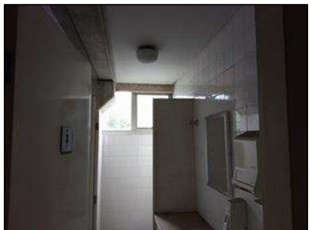
Foto 118 – Sanitário no 3º pavimento.
