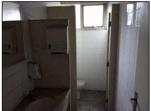
Foto 116 – Sanitário no 3º pavimento..
