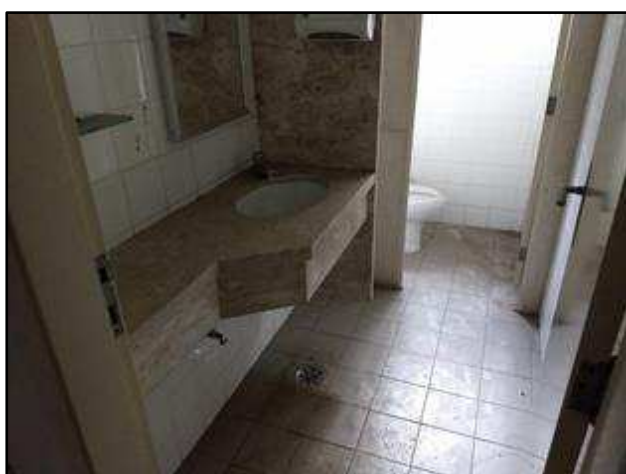
Foto 81 – Sanitário no 2º pavimento.
