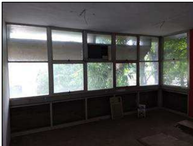
Foto 167 – Prédio 2 - 1º pavimento.
