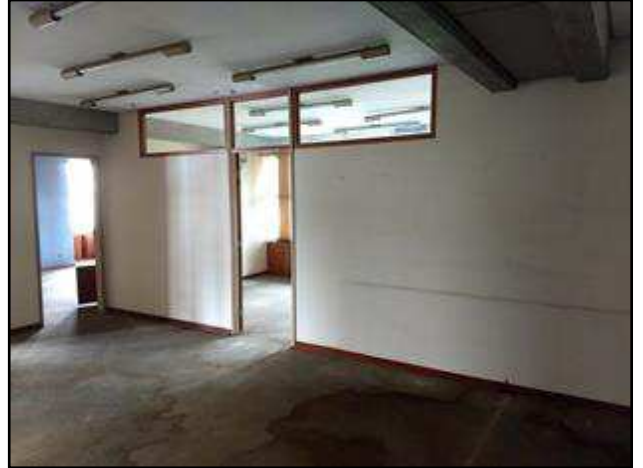
Foto 84 – Escritório 2 no 3º pavimento.
