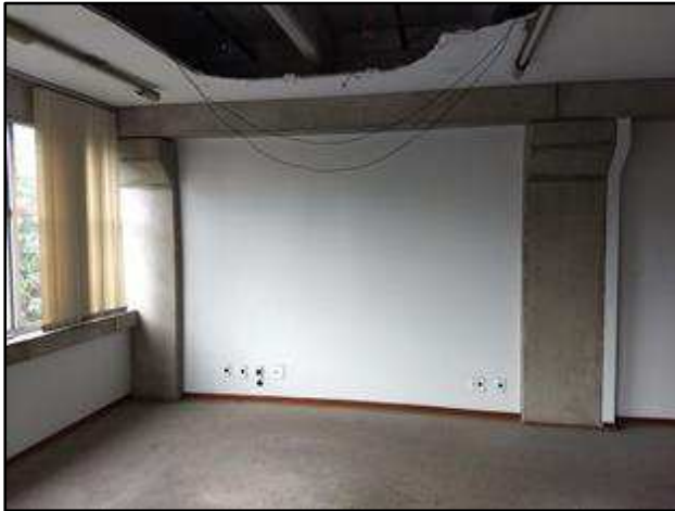
Foto 113 – Escritório 2 no 3º pavimento.
