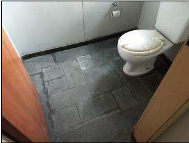
Foto 125 – Sanitário no 4º pavimento.
