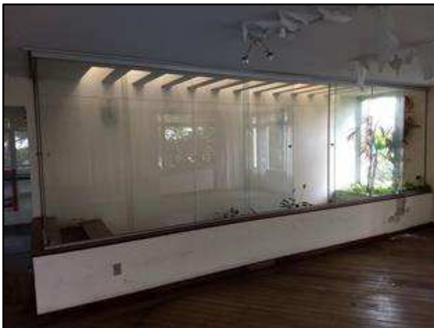
Foto 121 – Escritório 3 no 4º pavimento.
