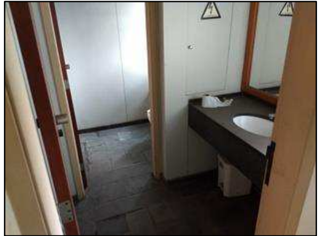
Foto 126 – Sanitário no 4º pavimento.
