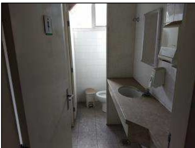
Foto 117 – Sanitário no 3º pavimento.
