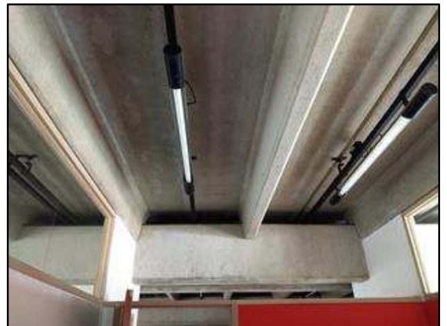
Foto 68 – Escritório 1 no 2º pavimento.
