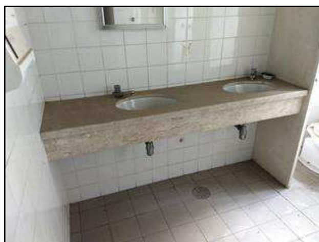
Foto 82 – Sanitário no 2º pavimento.
