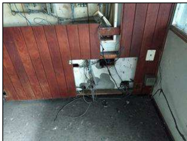
Foto 172 – Prédio 2 - 1º pavimento.
