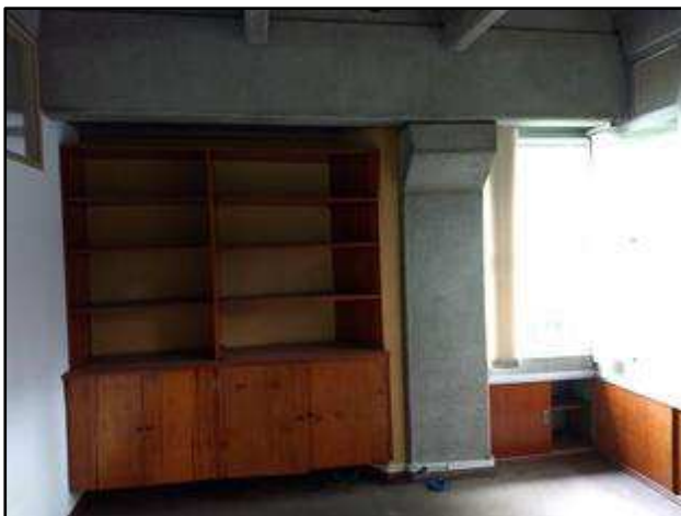
Foto 69 – Escritório 1 no 2º pavimento.
