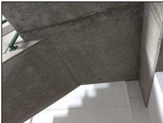
Foto 41 – Detalhe da estrutura da escada.
