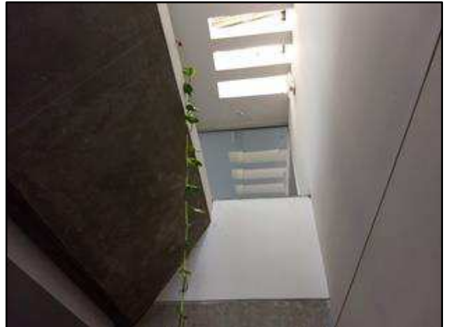
Foto 86 – Escritório 2 no 3º pavimento.
