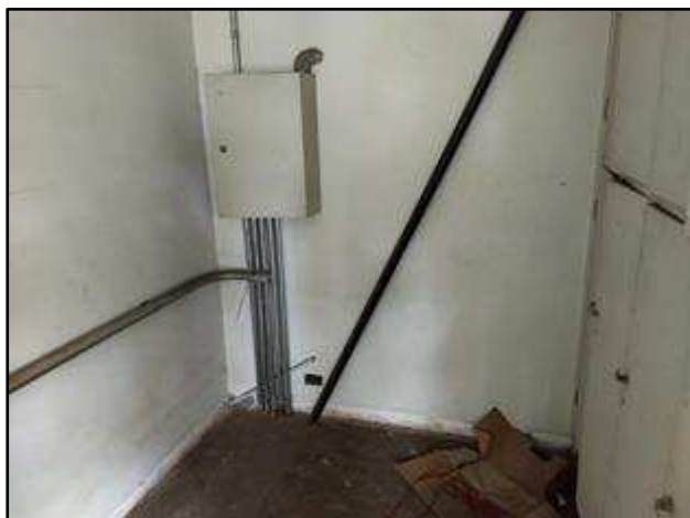
Foto 169 – Prédio 2 - 1º pavimento.
