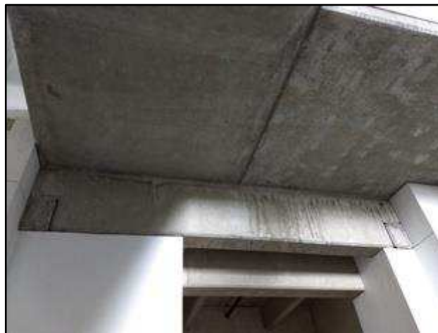
Foto 42 – Detalhe da estrutura da escada.
