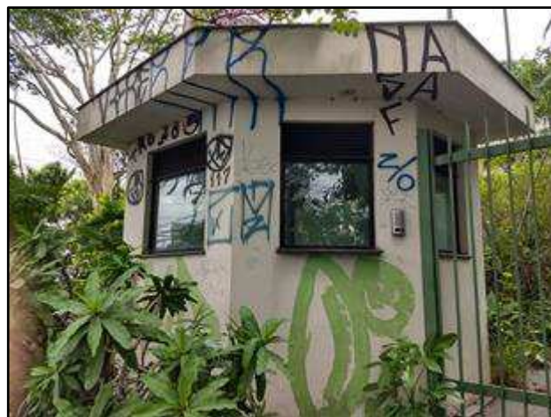
Foto 02 – Guarita fachada principal.
