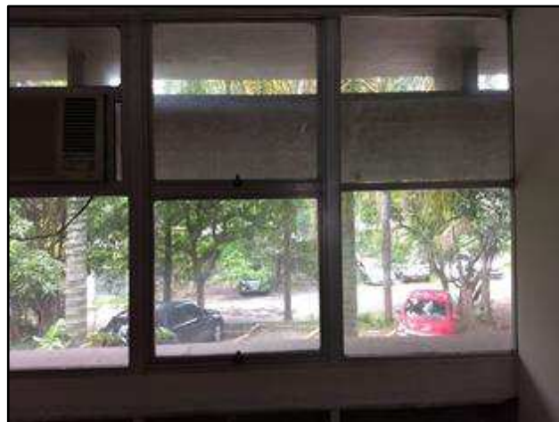
Foto 168 – Prédio 2 - 1º pavimento.
