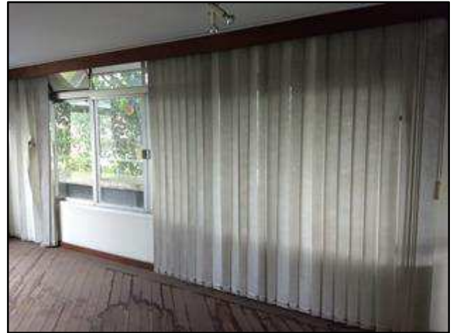
Foto 120 – Escritório 3 no 4º pavimento.
