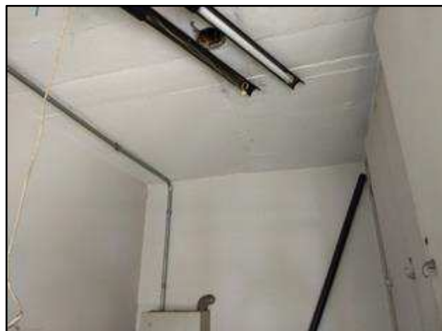
Foto 170 – Prédio 2 - 1º pavimento.
