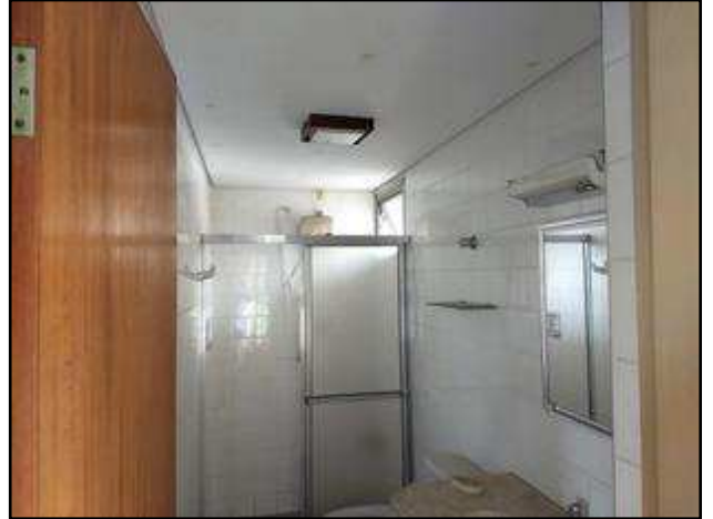
Foto 96 – Sanitário diretor no 3º pavimento.
