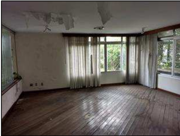
Foto 119 – Escritório 3 no 4º pavimento.
