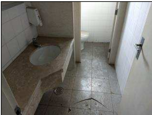
Foto 115 – Sanitário no 3º pavimento.
