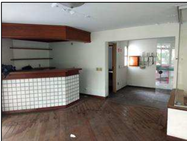
Foto 123 – Escritório 3 no 4º pavimento.
