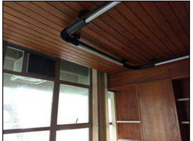
Foto 98 – Escritório 2 no 3º pavimento.
