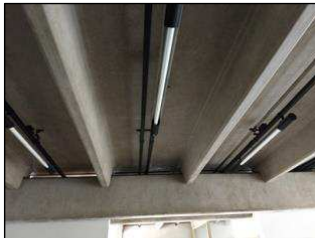
Foto 78 – Estrutura do 2º pavimento.
