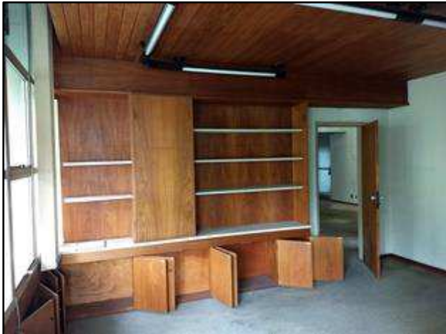
Foto 97 – Escritório 2 no 3º pavimento.
