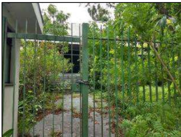
Foto 01 – Entrada fachada principal.
