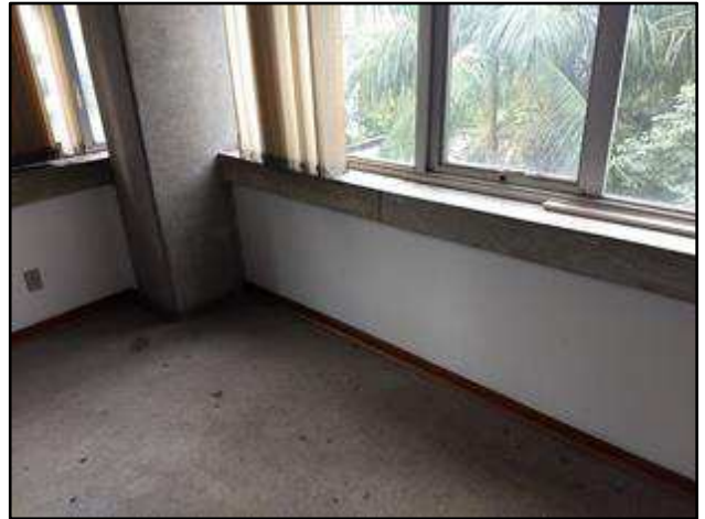
Foto 114 – Escritório 2 no 3º pavimento.
