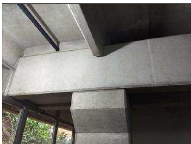
Foto 27 – Detalhe da estrutura do refeitório.
