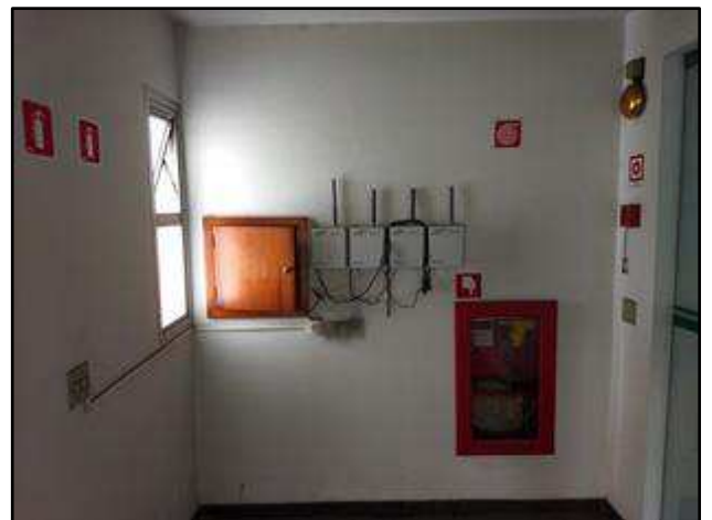
Foto 124 – Hall no 4º pavimento.
