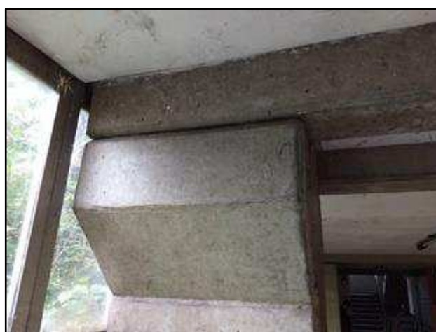
Foto 46 – Detalhe do pilar da passarela.
