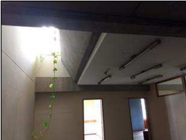
Foto 85 – Escritório 2 no 3º pavimento.
