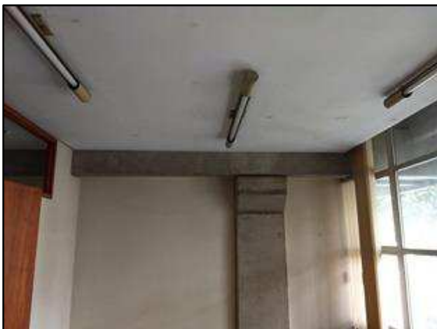
Foto 99 – Escritório 2 no 3º pavimento.
