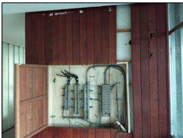
Foto 171 – Prédio 2 - 1º pavimento.
