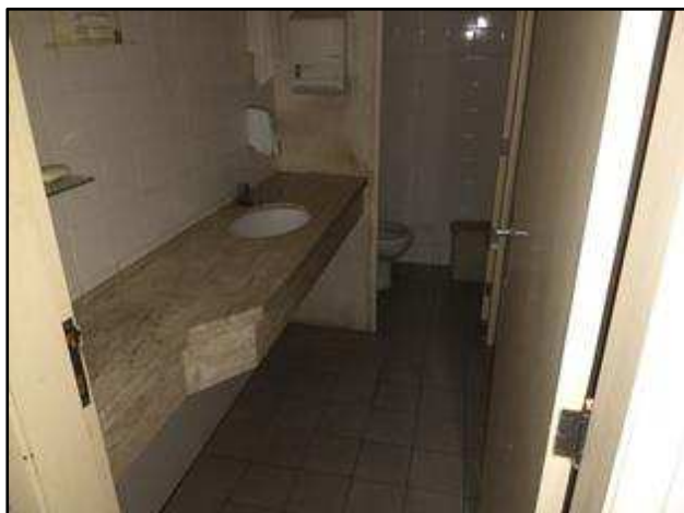
Foto 61 – Sanitário escritório 1º pavimento.
