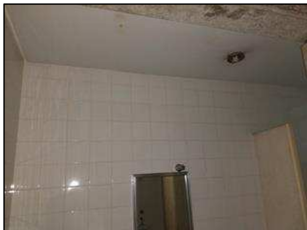
Foto 62 – Sanitário escritório 1º pavimento.
