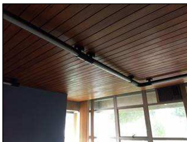
Foto 94 – Escritório 2 no 3º pavimento.
