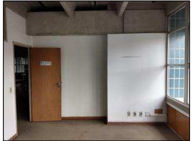
Foto 66 – Escritório 1 no 2º pavimento.
