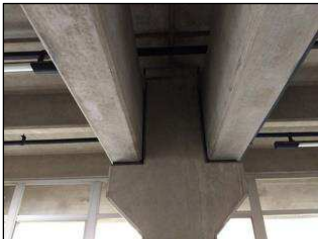
Foto 77 – Estrutura do 2º pavimento.
