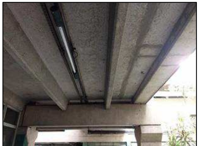
Foto 22 – Laje do acesso ao refeitório.
