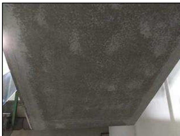
Foto 44 – Detalhe da estrutura da escada.
