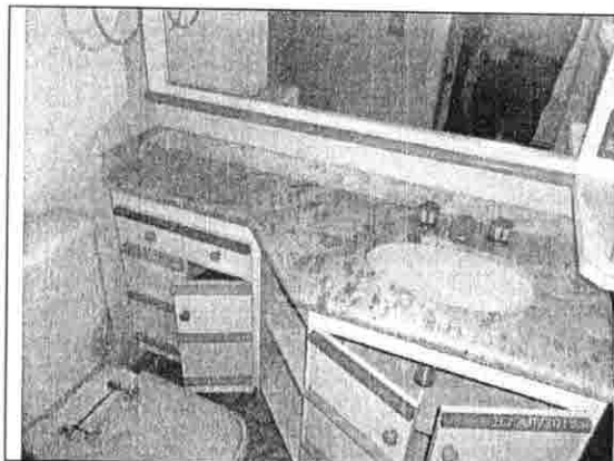
Foto n.º 36. Vista do banheiro da suíte n.º 4 do imóvel avaliando.
