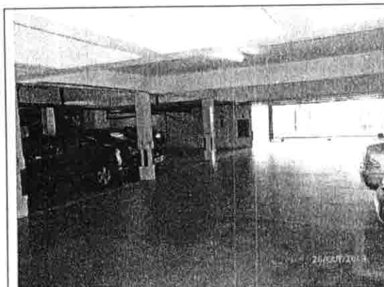
Foto n.º 3. Vista do acesso ao pavimento subsolo no sentido da frente do imóvel.
