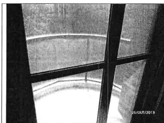
Foto n.º 30. Vista do terraço da suíte n.º 2 do imóvel avaliando.
