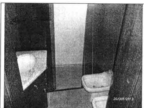
Foto n.º 34. Vista do banheiro da suíte n.º 3 do imóvel avaliando.
