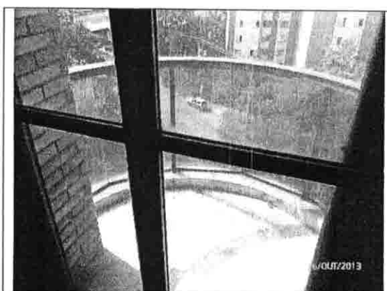
Foto n.º 33. Vista do terraço da suíte n.º 3 do imóvel avaliando.
