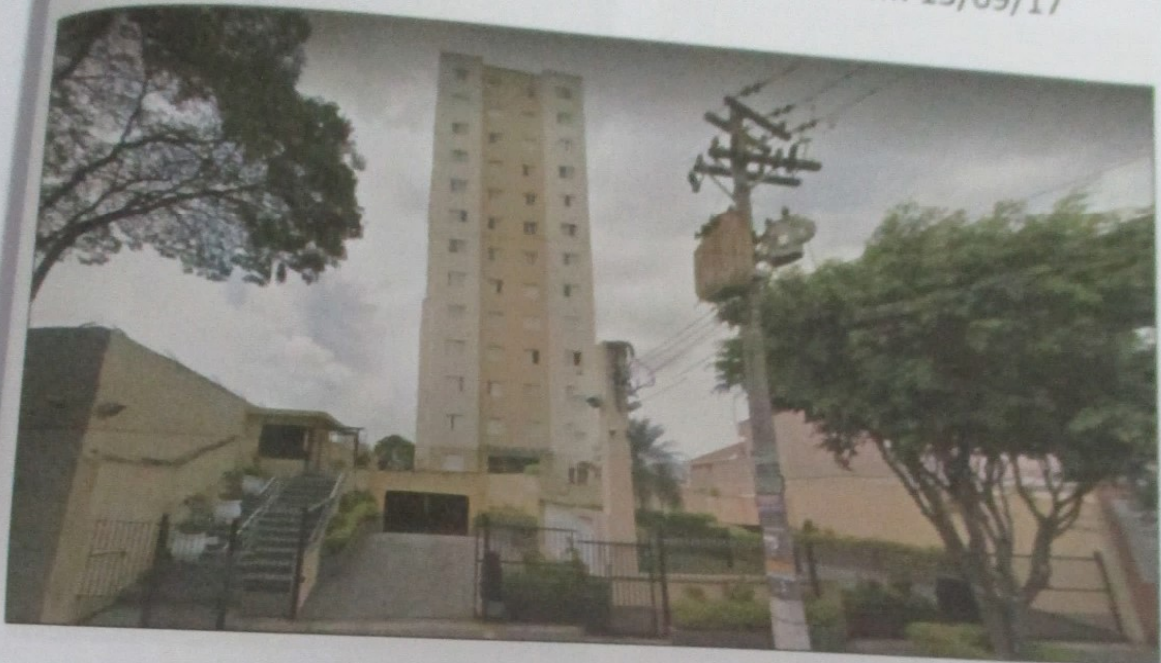
FOTO 01 - Fachada da portaria e bloco 01
