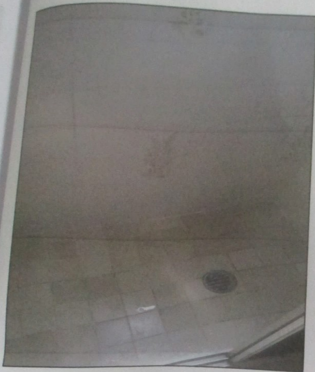
Foto 27 - Piso do box do banheiro social
