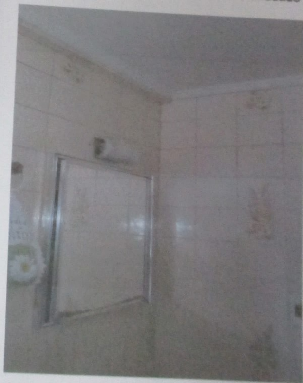
Foto 26 - Detalhe do banheiro
