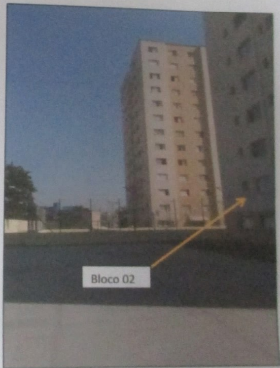
Foto 03 - Lateral dos blocos 01 e 02 do condomínio
