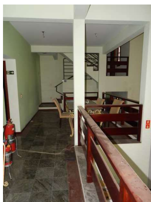
23 - DSCN4049.JPG Edificação - Térreo - Área de entrada e mezanino.
