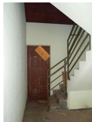
12 - DSCN4016.JPG Área externa - Acesso à lavanderia.
