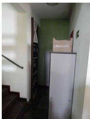
71 - DSCN4087.JPG Edificação - Inferior - Despensa abaixo da escada.
