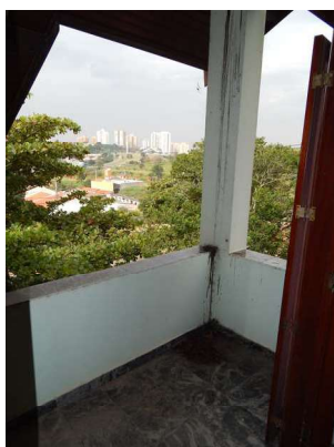
61 - DSCN4079.JPG Edificação - Superior - Varanda da suíte.
