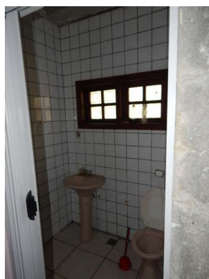
79 - DSCN4104.JPG Edícula - Inferior - Banheiro.
