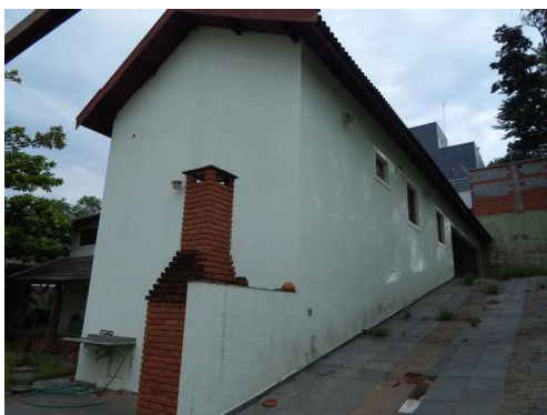
09 - DSCN4014.JPG Área externa - Fachada de fundos e rampa de acesso à garagem.
