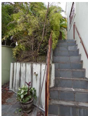
15 - DSCN4089.JPG Área externa - Escada de acesso no recuo frontal.
