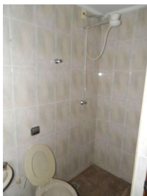
37 - DSCN4025.JPG Edificação - Térreo acima - WC
