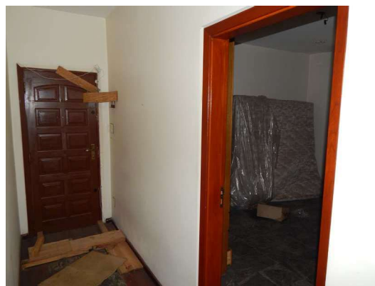
42 - DSCN4056.JPG Edificação - Térreo acima - Dormitório 1.
