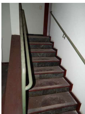
59 - DSCN4075.JPG Edificação - Superior - Escada de acesso à suíte.
