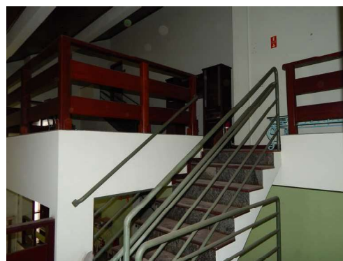
56 - DSCN4072.JPG Edificação - Térreo acima - Escada de acesso ao superior.
