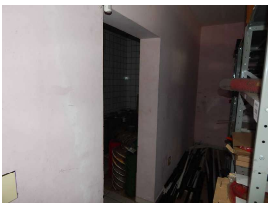
75 - DSCN4098.JPG Edícula - Inferior - Salão.
