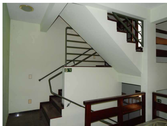
38 - DSCN4051.JPG Edificação - Térreo - Escada de acesso aos dormitórios
