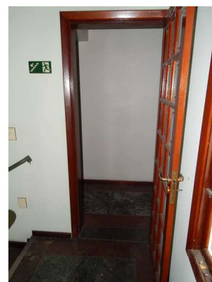
40 - DSCN4053.JPG Edificação - Térreo acima - Hall acesso aos dormitórios
