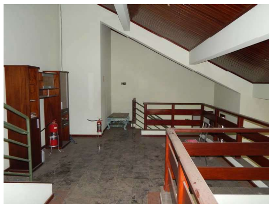
58 - DSCN4074.JPG Edificação - Superior - Sala.
