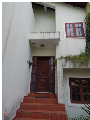
17 - DSCN4088.JPG Área externa - Porta de entrada da sala.
