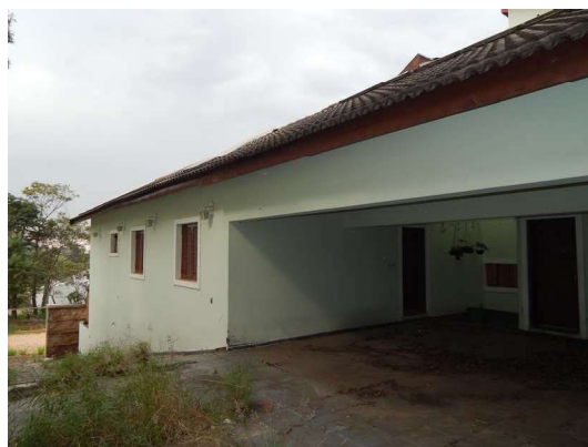
10 - DSCN4018.JPG Área externa - Fachada de fundos e garagem.
