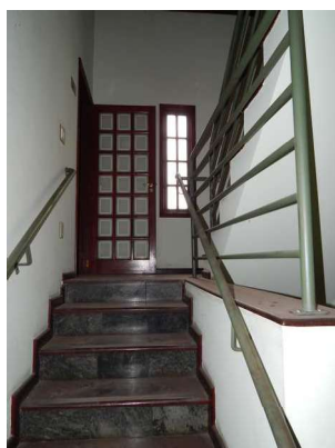
39 - DSCN4052.JPG Edificação - Térreo - Escada de acesso aos dormitórios.
