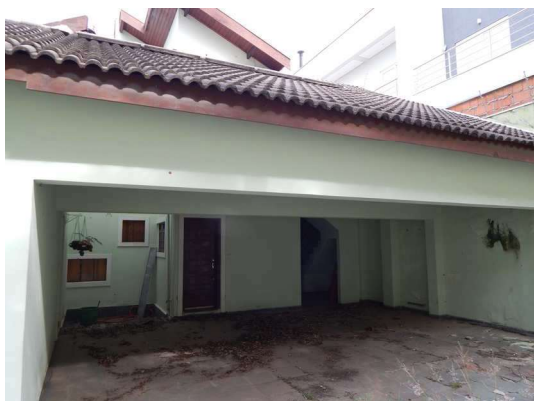
11 - DSCN4015.JPG Área externa - Garagem.
