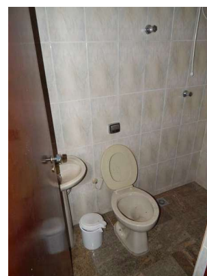
36 - DSCN4026.JPG Edificação - Térreo acima - WC
