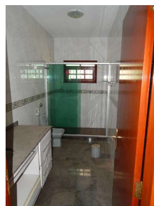
52 - DSCN4065.JPG Edificação - Térreo acima - Banheiro.
