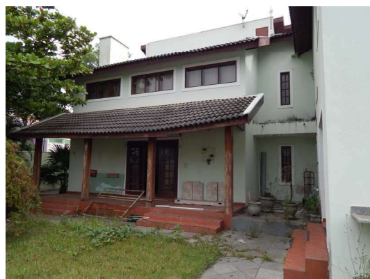
08 - DSCN4013.JPG Área externa - Fachada lateral.
