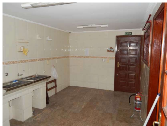
34 - DSCN4023.JPG Edificação - Térreo acima - Área de serviço.
