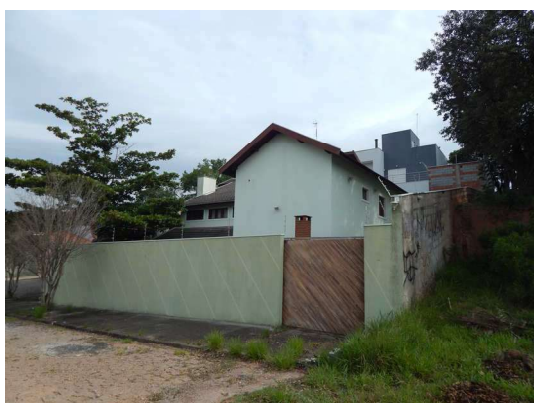
03 - DSCN4110.JPG Rua - Frente para a Rua João Levada.
