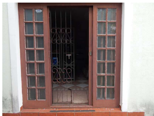
72 - DSCN4095.JPG Edícula - Inferior - Entrada.
