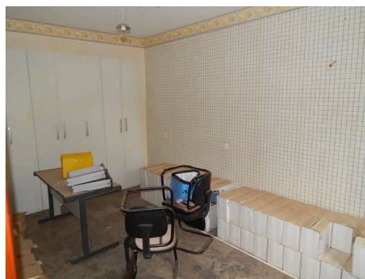
54 - DSCN4067.JPG Edificação - Térreo acima - Dormitório 3.
