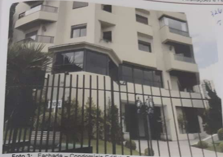
Foto 3: Fachada – Condomínio Edifício Panorama
