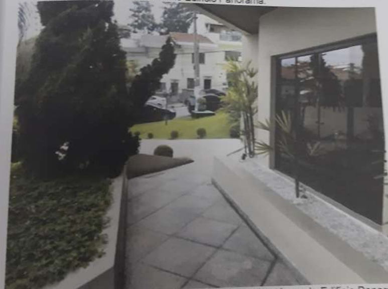
Foto 4: Vista área comum externa comum do piso térreo do Edifício Panorama.
