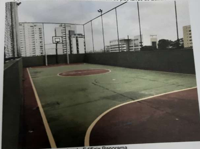
Foto 6: Vista da quadra do Edifício Panorama.
