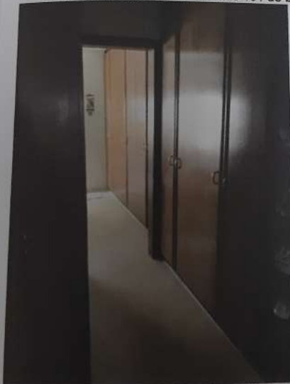
Foto 22: Vista do dormitório da unidade 101 do bloco 2 do Edifício Panorama.
