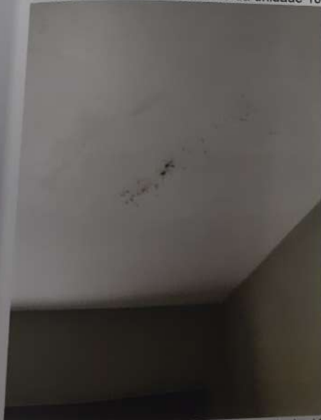
Foto 24: Vista do dormitório da unidade 101 do bloco 2 do Edifício Panorama.
