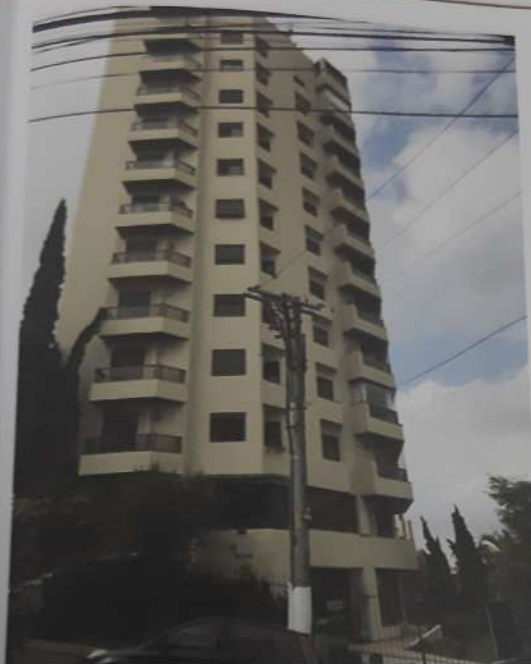
Foto 2: Fachada – Condomínio Edifício Panorama.
