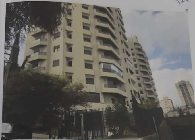
Foto 1: Fachada – Condomínio Edifício Panorama.
