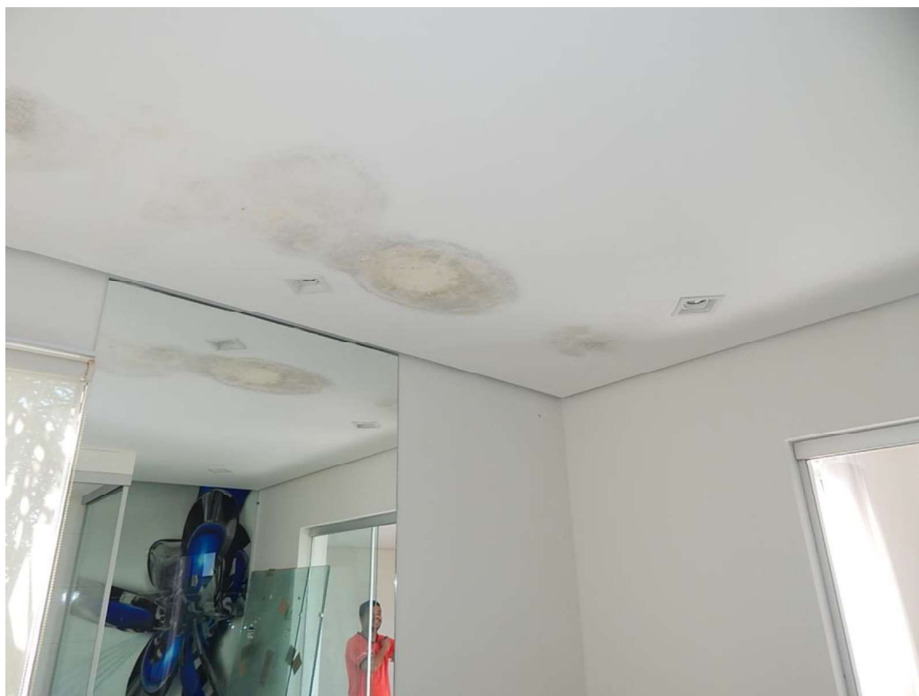
FOTO 28 – BANHEIRO SUITE MASTER – DETALHE FORRO GESSO
