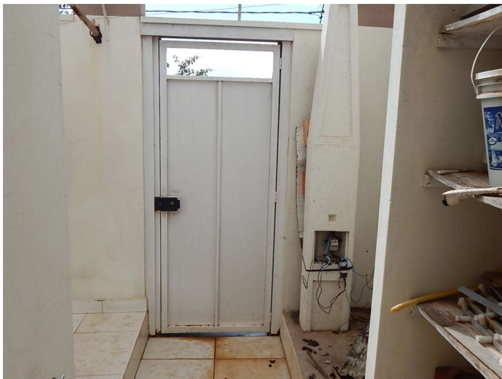
FOTO 32 – PORTÃO DE ACESSO FUNDOS
