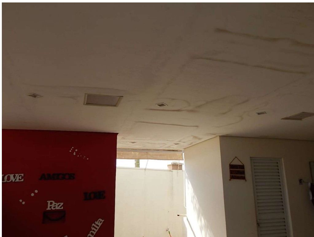
FOTO 05 – VISTA PARCIAL INTERNA GARAGEM – DETALHE FORRO DE GESSO
