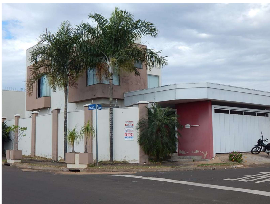
FOTO 02 – VISTA GERAL FRENTE
