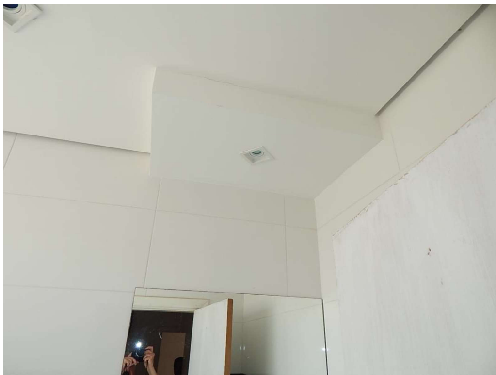
FOTO 18 –PARCIAL BANHEIRO SUITE TERREO
