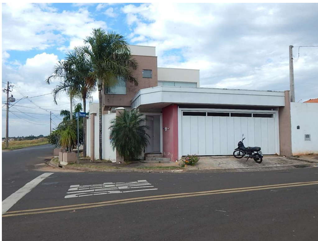
FOTO 01 – VISTA GERAL FRENTE
