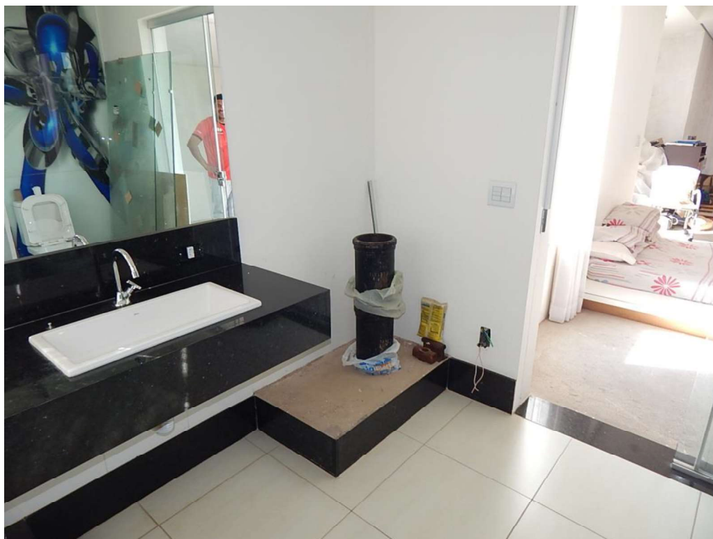
FOTO 29 –VISTA PARCIAL BANHEIRO SUITE MASTER
