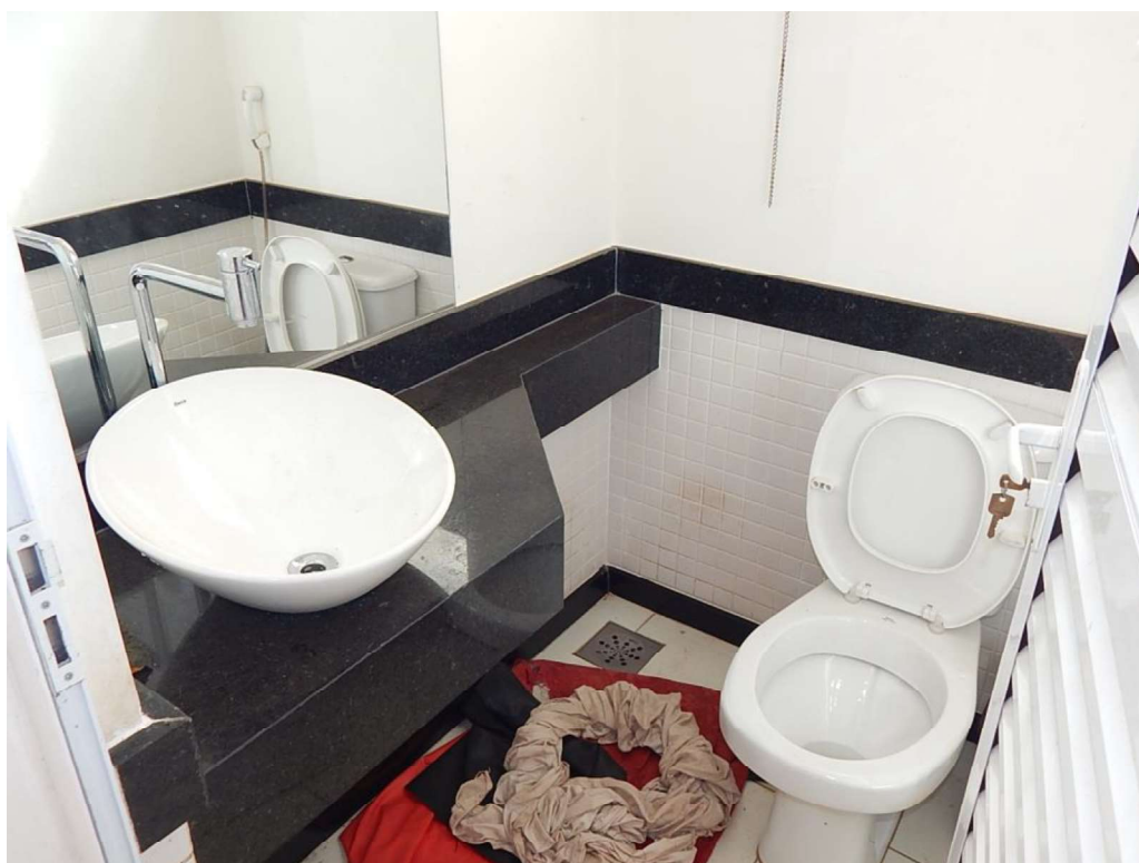
FOTO 07 – VISTA PARCIAL INTERNA BANHEIRO TÉRREO
