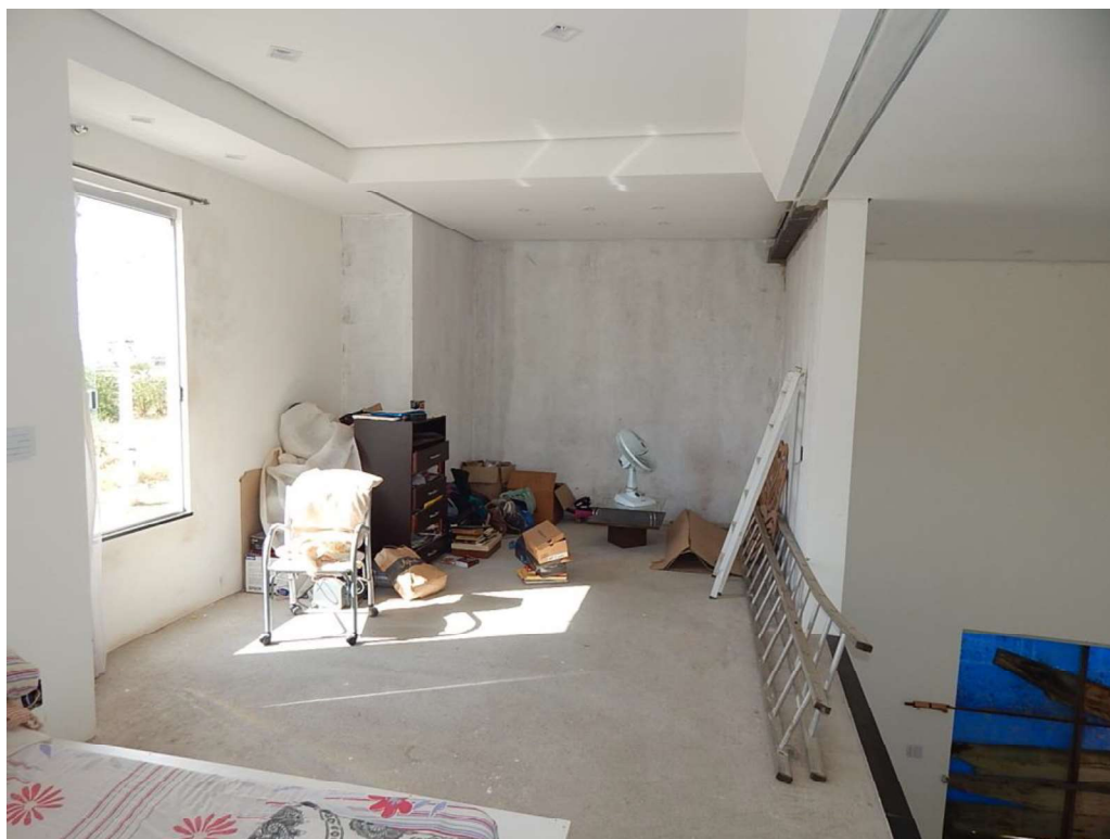
FOTO 25 – VISTA PARCIAL SUITE MASTER MEZANINO
