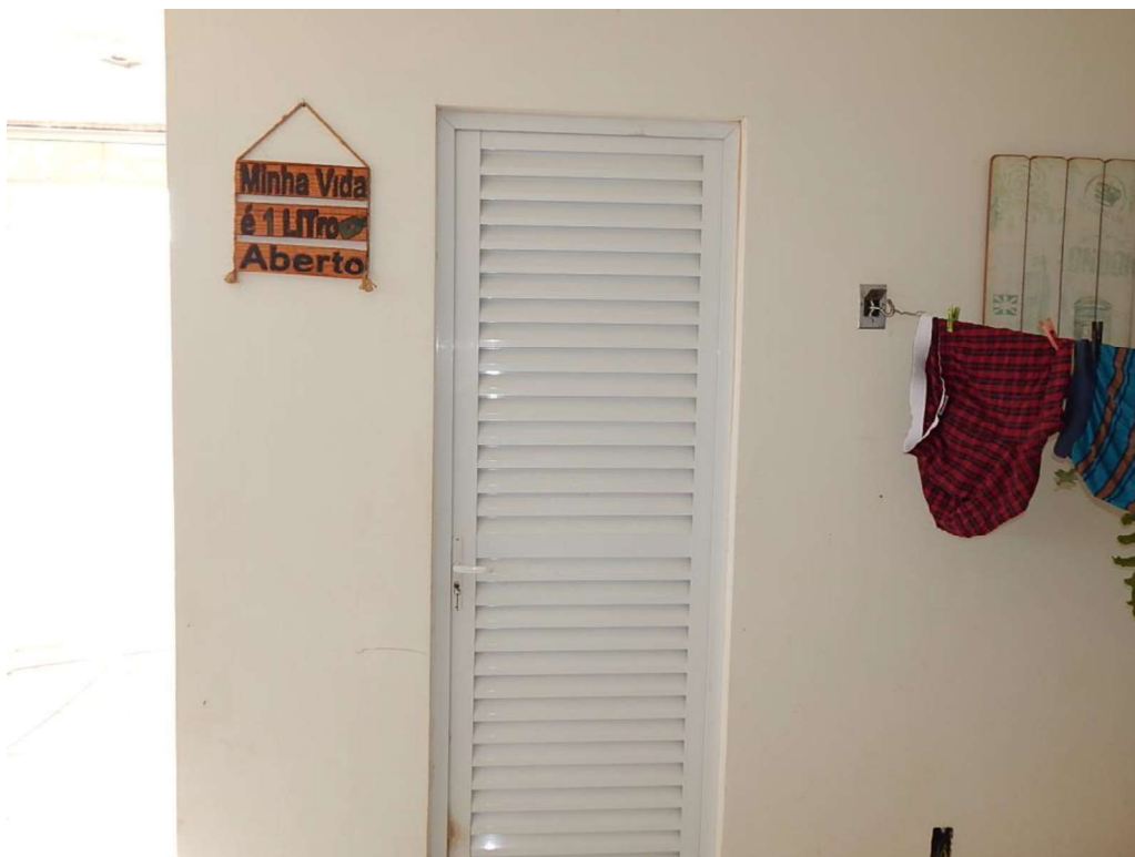
FOTO 06 – PORTA DE ACESSO BANHEIRO TÉRREO
