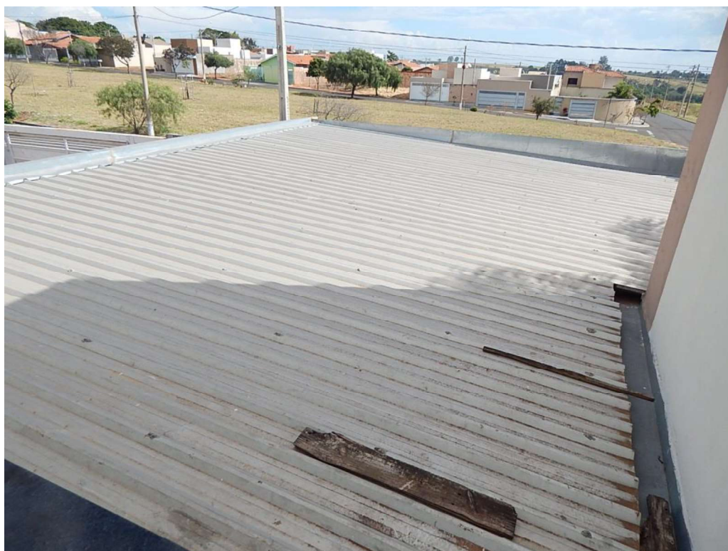
FOTO 30 – VISTA DA COBERTURA METÁLICA DA GARAGEM
