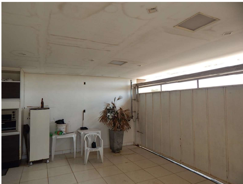
FOTO 03 – VISTA INTERNA GARAGEM
