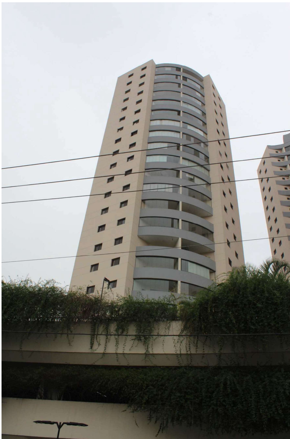
Condomínio Residencial Ilhas Polinésias – Edifício Kauai (Vista da Rua).
