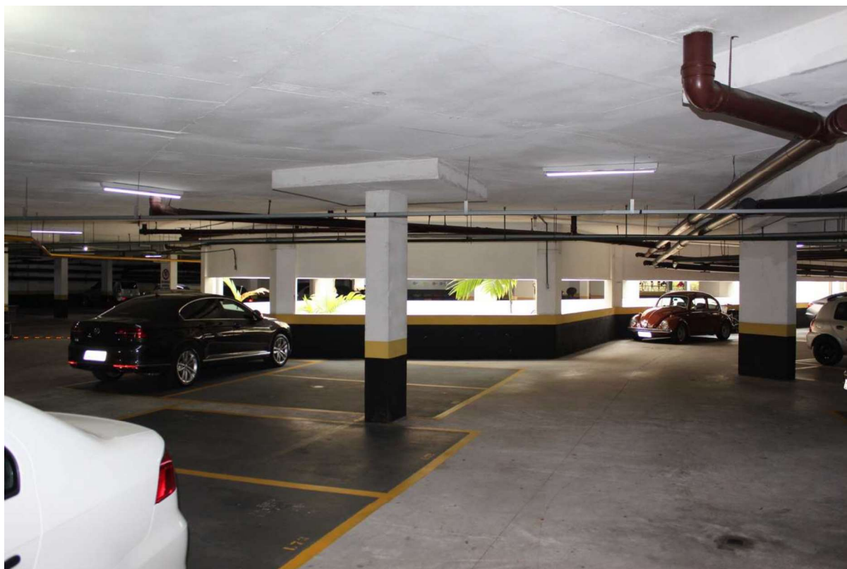
Condomínio Residencial Ilhas Polinésias – Garagem.
