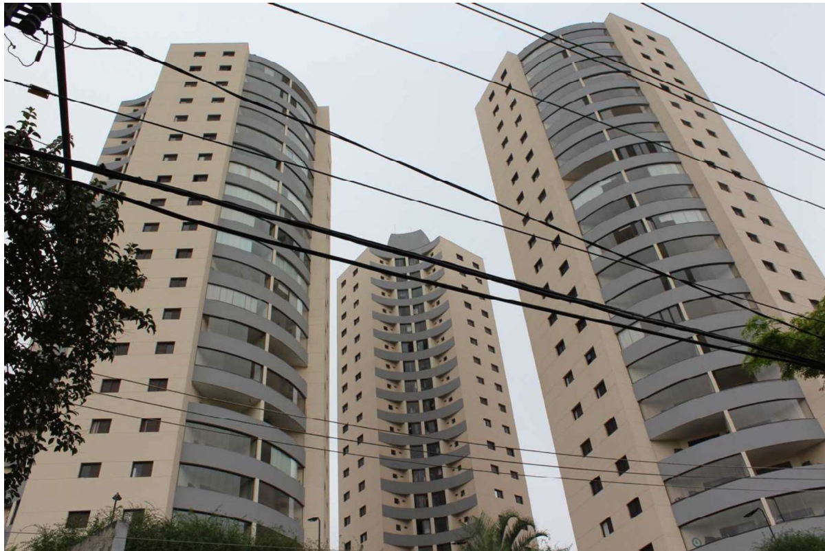
Condomínio Residencial Ilhas Polinésias – Edifícios.
