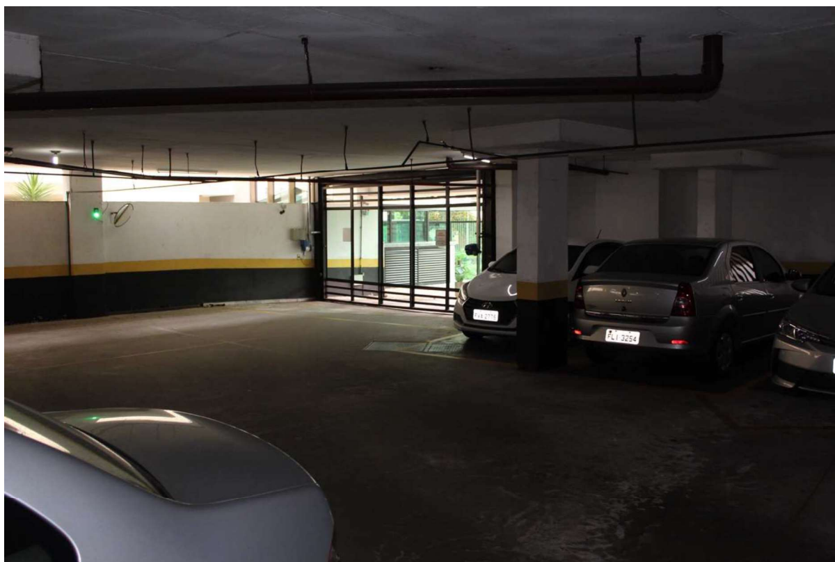
Condomínio Residencial Ilhas Polinésias – Garagem.
