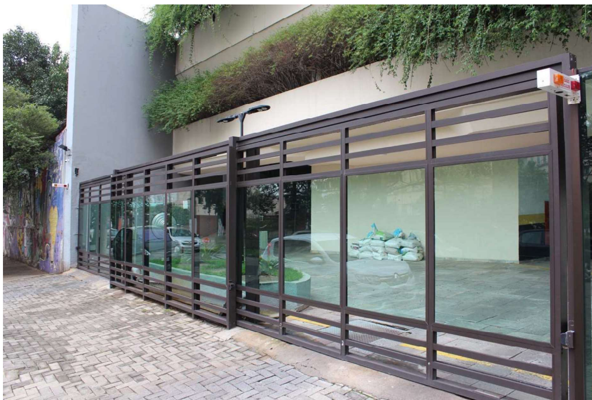
Condomínio Residencial Ilhas Polinésias – Entrada de Veículos.
