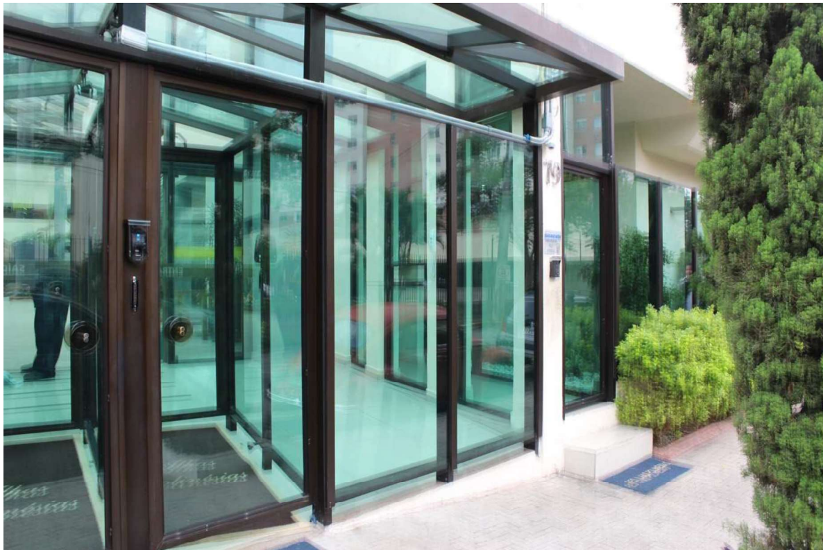
Condomínio Residencial Ilhas Polinésias – Entrada de Pedestres.
