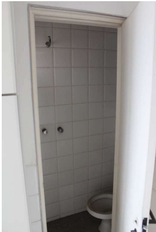
Apartamento 82 (Edifício Kauai) – WC Serviço
