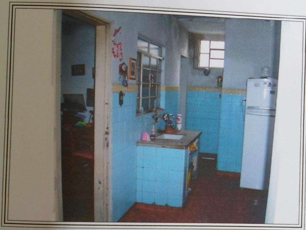
FOTO 17 : Vista da cozinha da mesma edificação.
