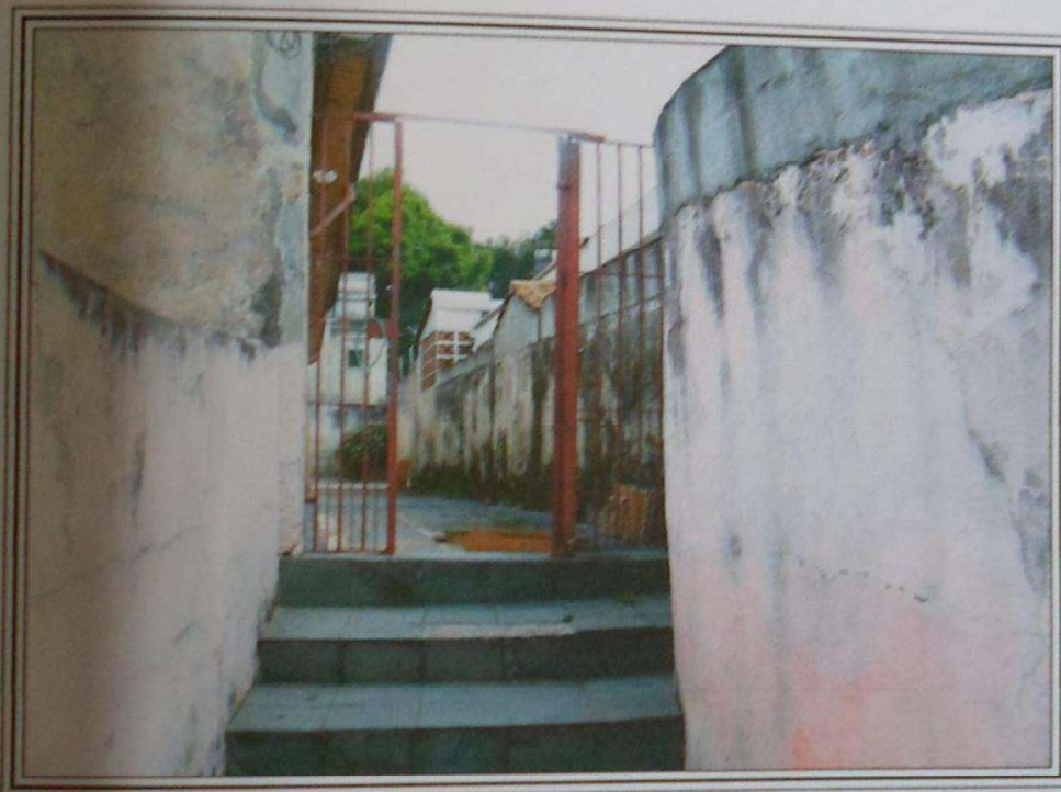
FOTO 09 : Outro ângulo da escada, notando-se o terreno que está acima de 2,00m do nível da Rua Ribeirão Branco.
