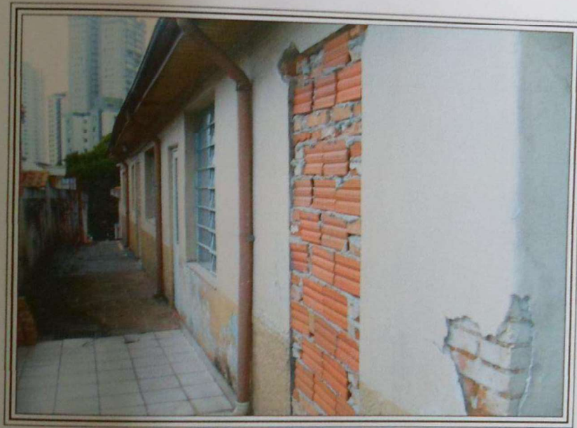
FOTO 13 : Outro ângulo das edificações interligadas existentes no imóvel avaliando.
