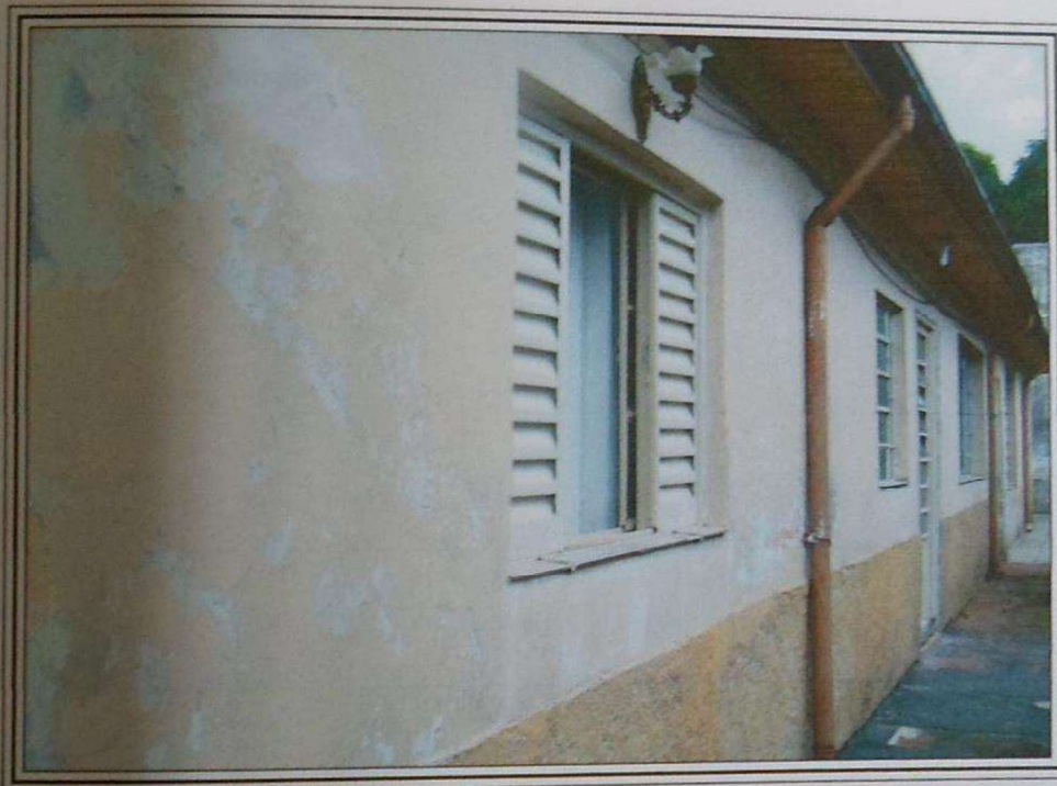
FOTO 10 : Vista parcial das edificações interligadas existentes no imóvel avaliando.
