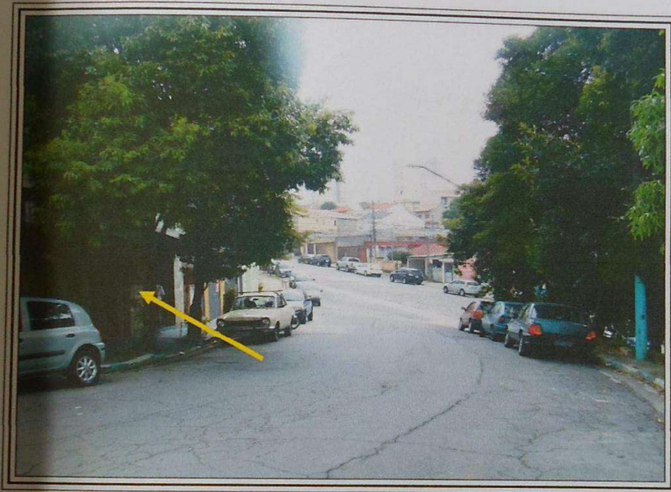
FOTO 01 : Vista parcial da Rua Ribeirão Branco, notando-se o imóvel avalian- do, à esquerda, onde apontado.
