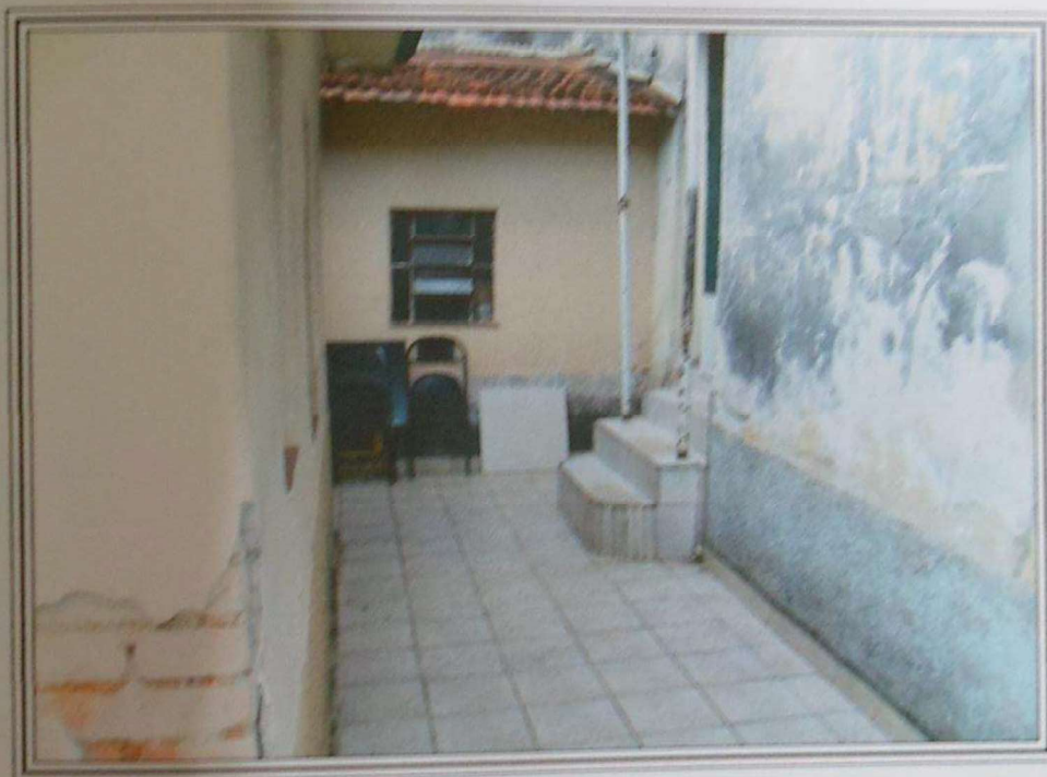
FOTO 14 : Outro ângulo das edificações interligadas existentes no imóvel avaliando.
