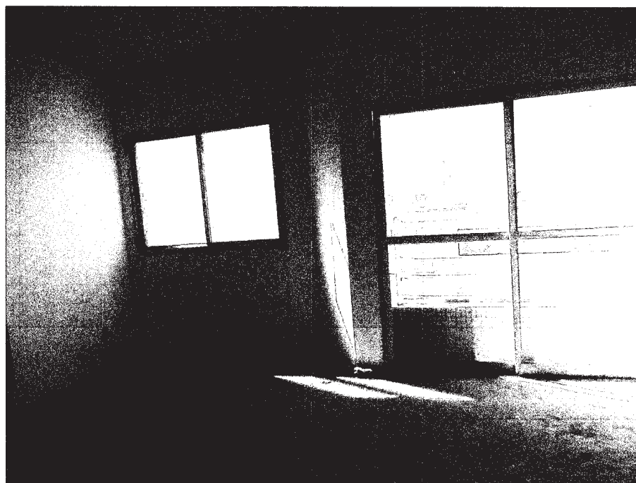
FOTO 07:- Vista da sala do imóvel.
