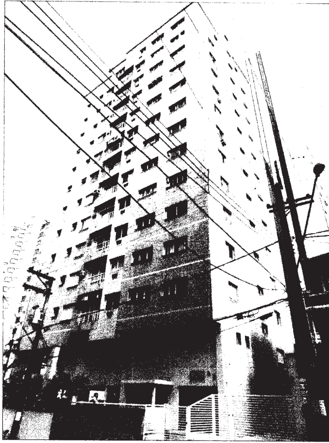
FOTO 2: Vista da fachada do prédio.
