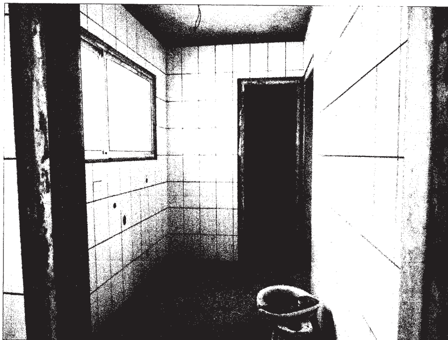
FOTO 08:- Vista da área de serviço do imóvel.
