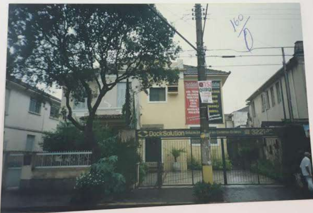
FOTO 03: - Vista da fachada principal do imóvel.
