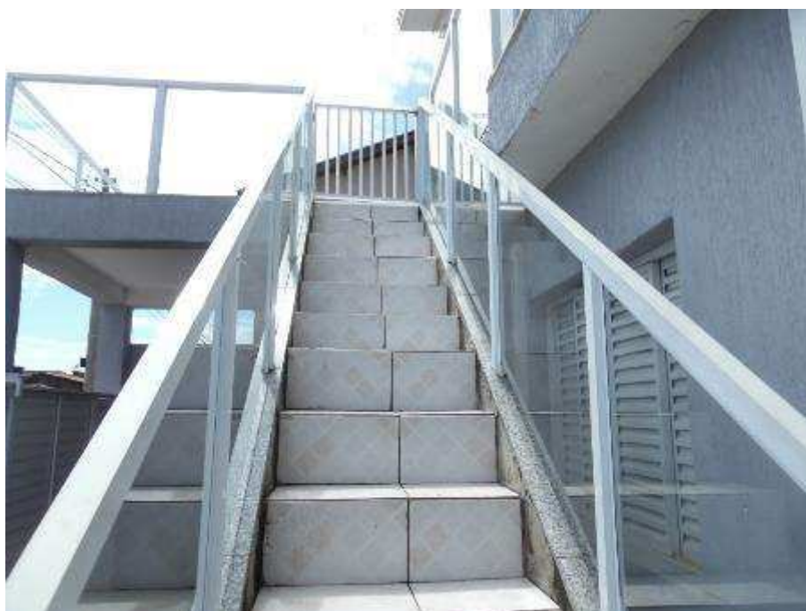
Escada de acesso ao pavimento superior.
