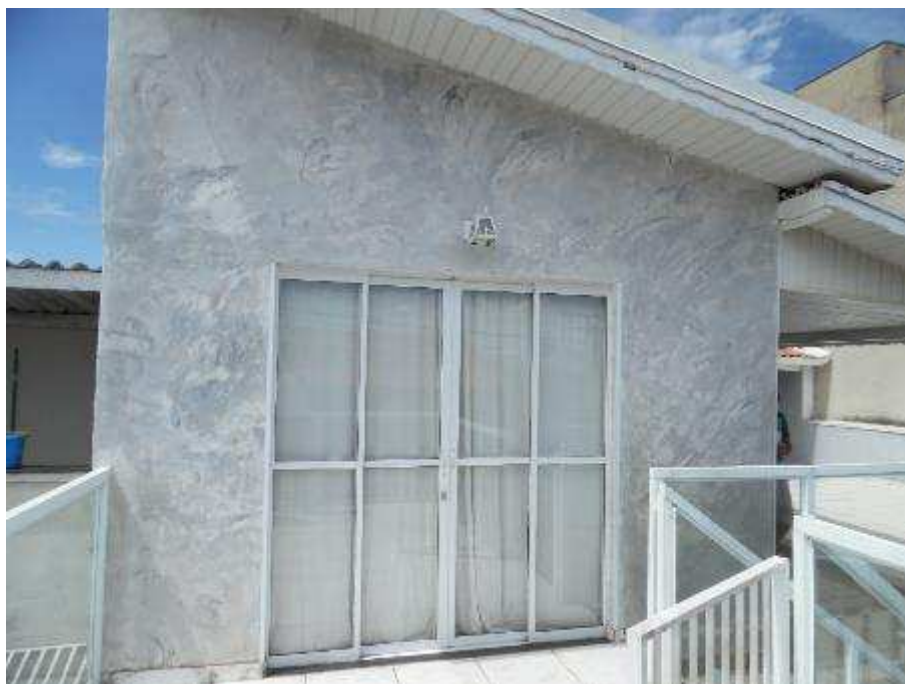
Fachada do pavimento superior.
