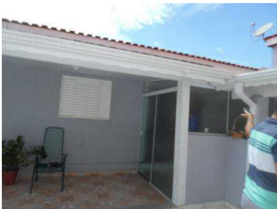
Mais uma foto mostrando a área construída a qual este Auxiliar do Juízo não teve acesso
