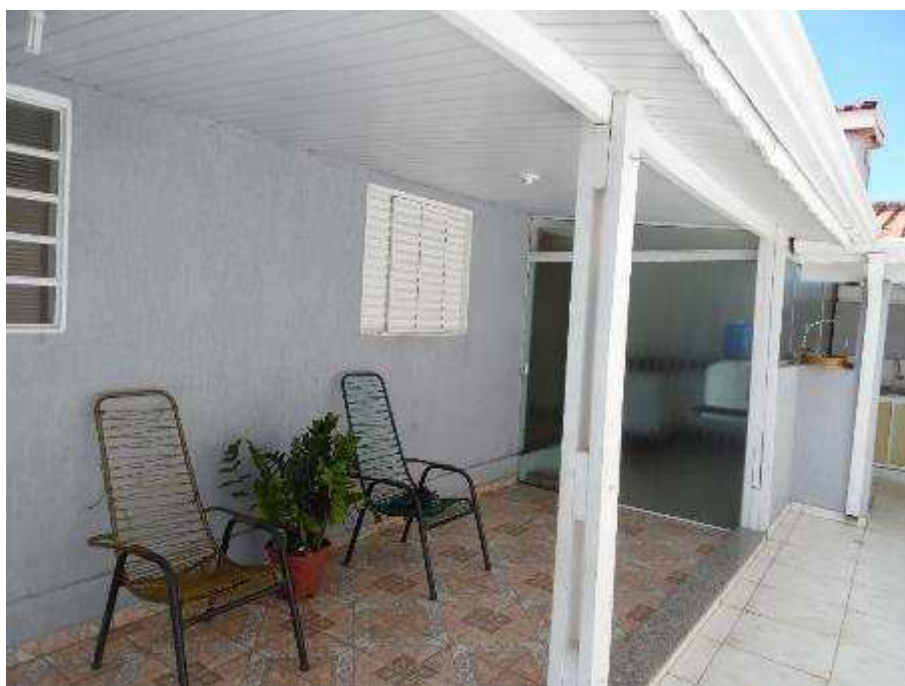
Vista da parte externa da área construída a qual este Auxiliar do Juízo não teve acesso.
