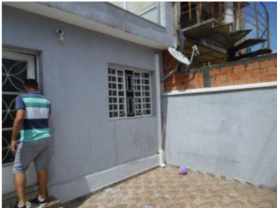
Parte da fachada do pavimento térreo.
