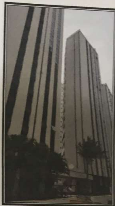
Figura 4 - Fachada do Condomínio
