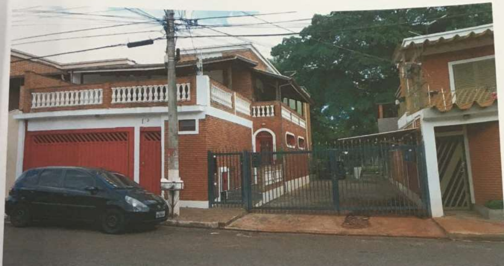
FOTO 01 – Vista da fachada de uma unidade residencial do Condomínio Rosa dos Ventos com características construtivas semelhantes ao imóvel em questão.
