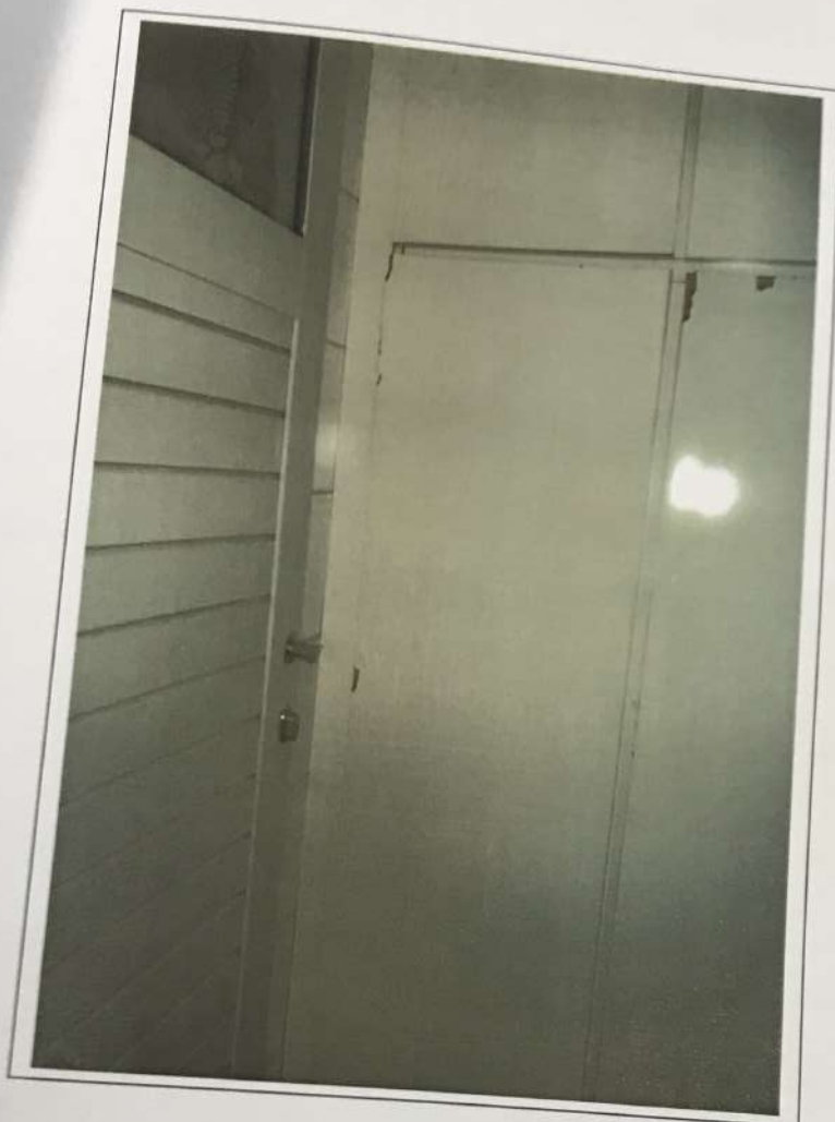
Foto 13: Vista da despensa.
