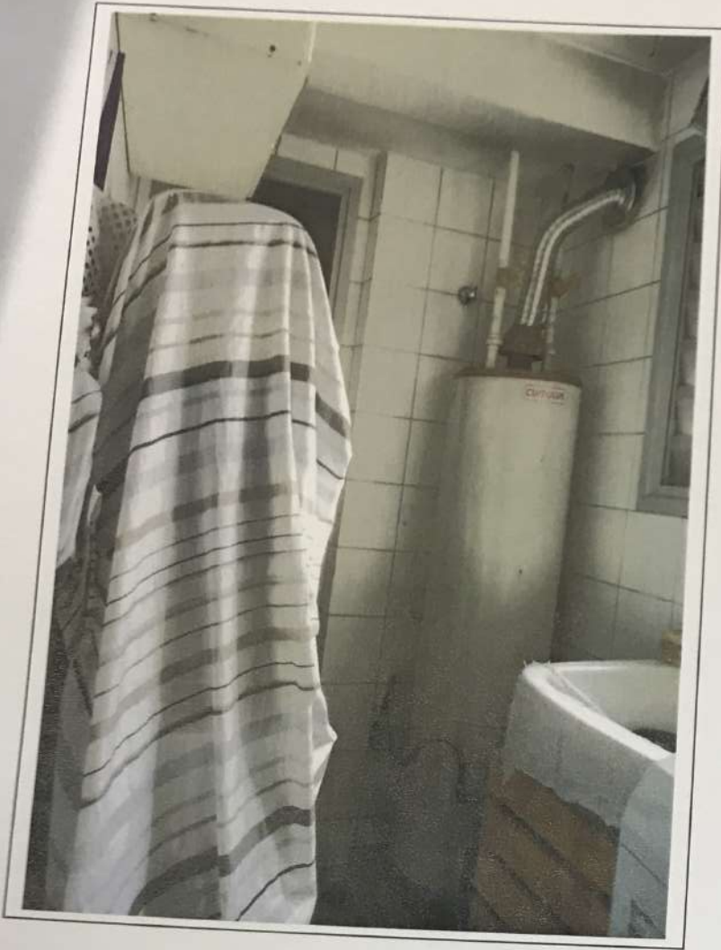
Foto 12: Vista da área de serviço com os mesmos acabamentos da cozinha.
