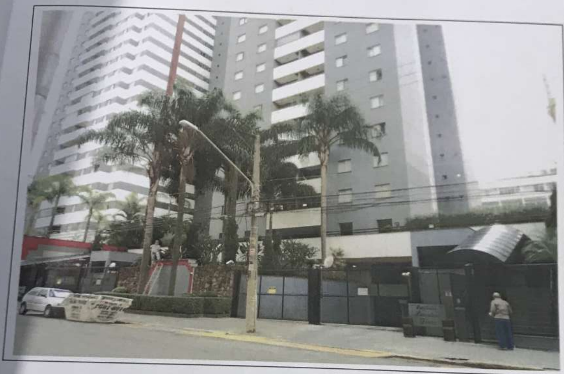
Foto 03: Vista da fachada do Edifício Fiore sob nº 195 da Rua Marina Cintra.
