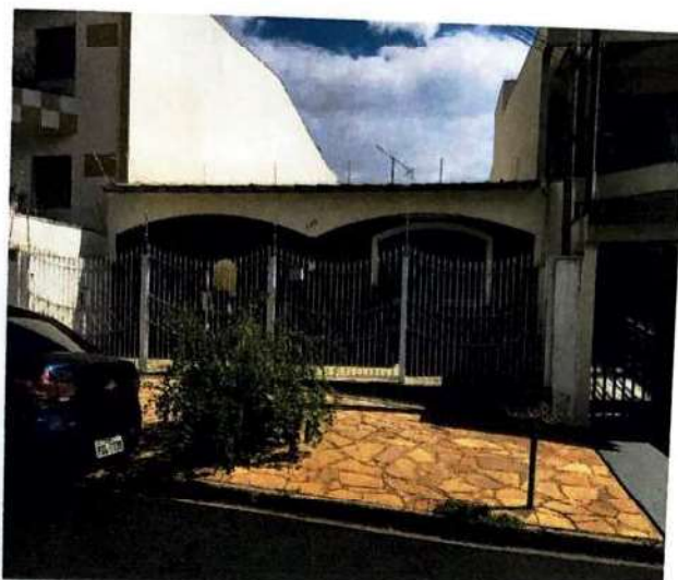
Foto 3 – Vista frontal do imóvel avaliando – Rua Batatais, 845
