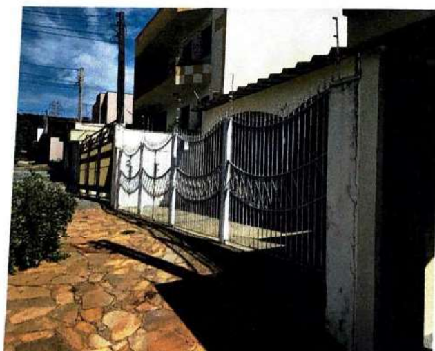
Foto 4 – Detalhe frontal do imóvel avaliando
