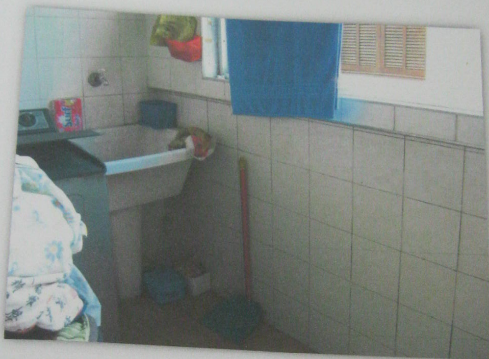
FOTO 07: - Vista da área de serviço.
