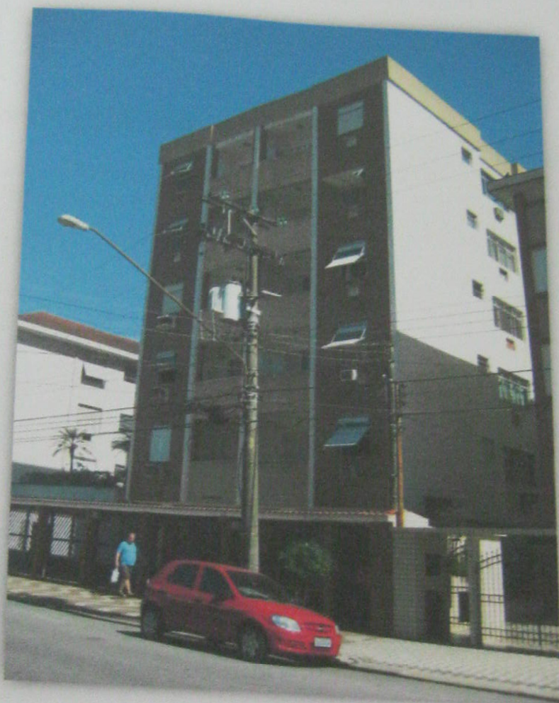
FOTO 02: - Vista da fachada do Edifício do imóvel.
