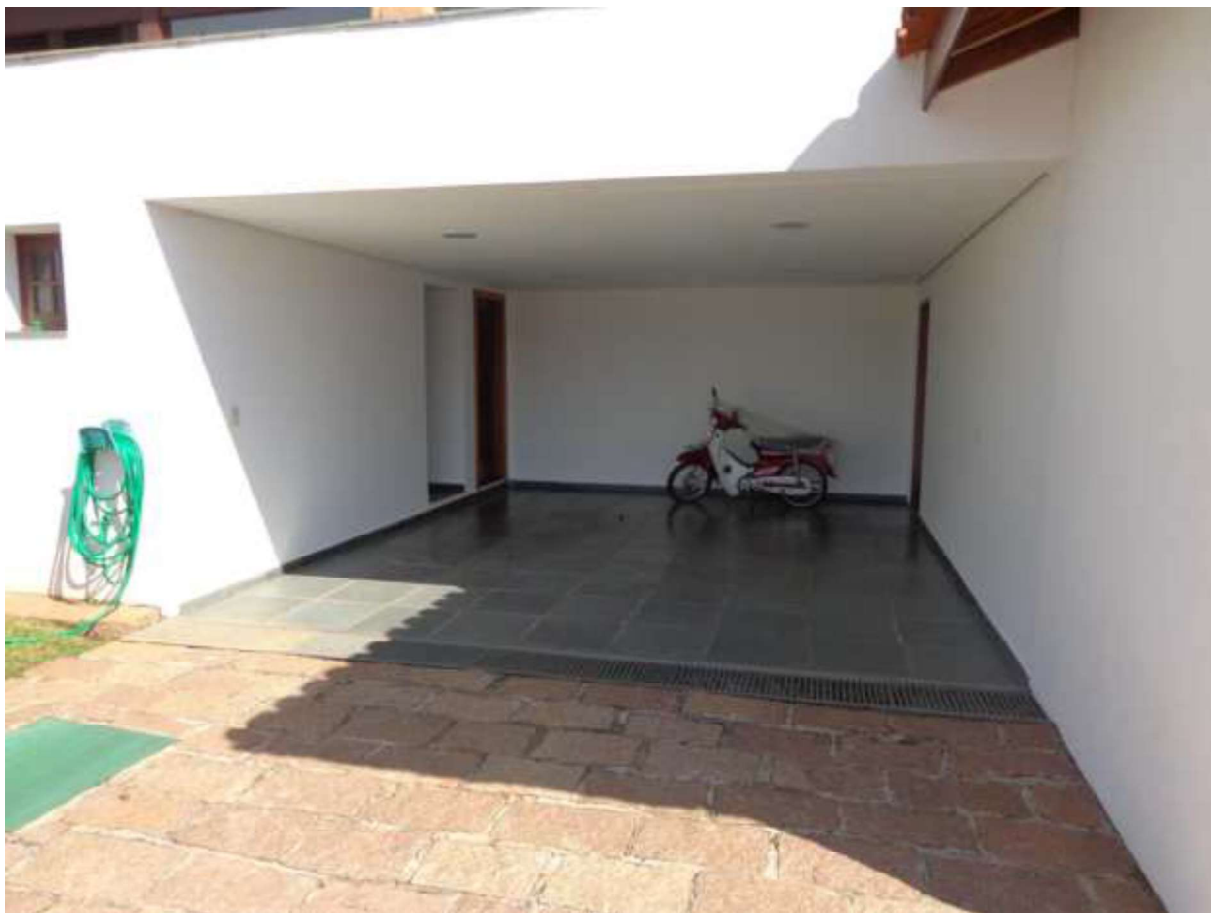
Aspectos do acesso aos vestiários
