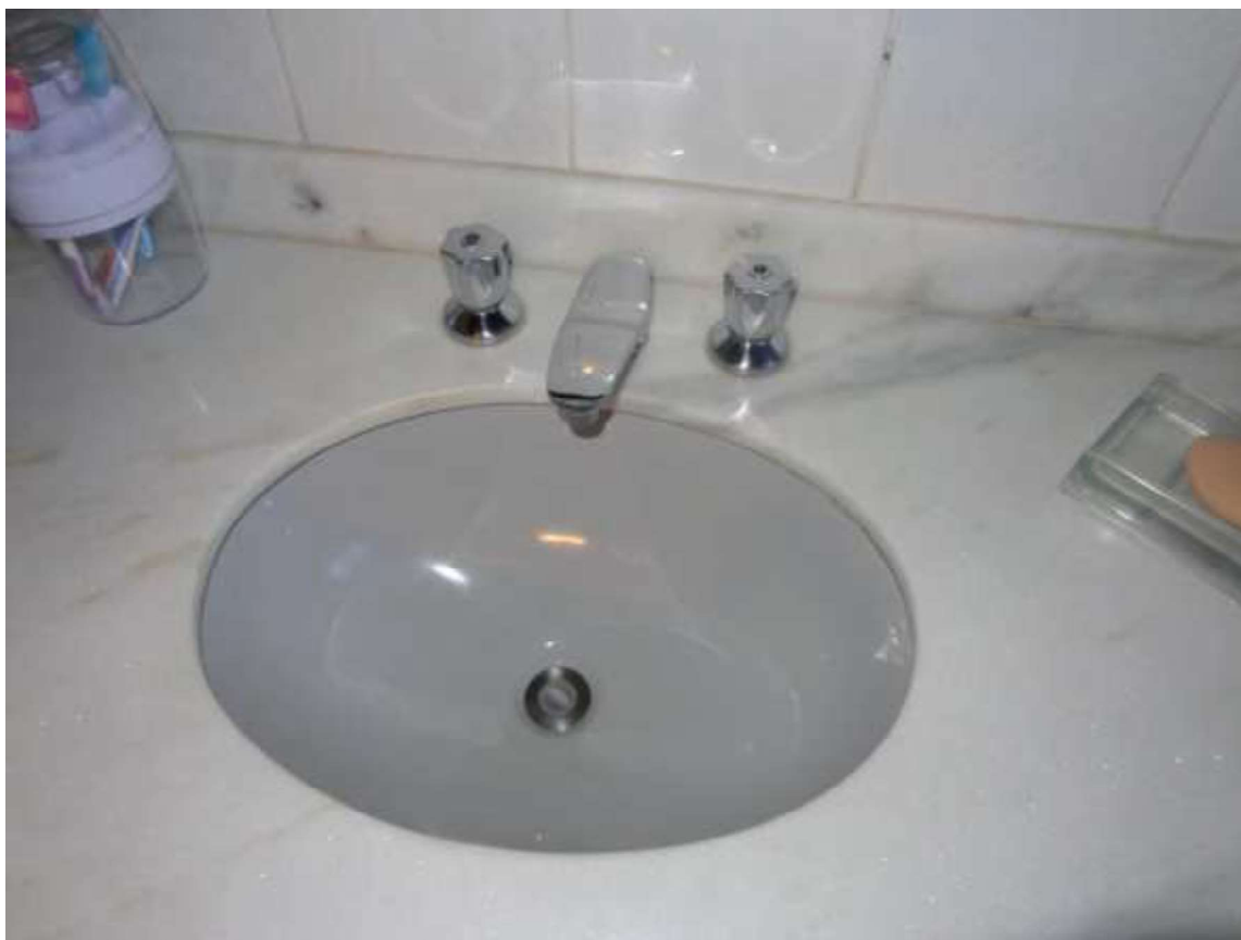
Aspectos dos metais sanitários nos banheiros
