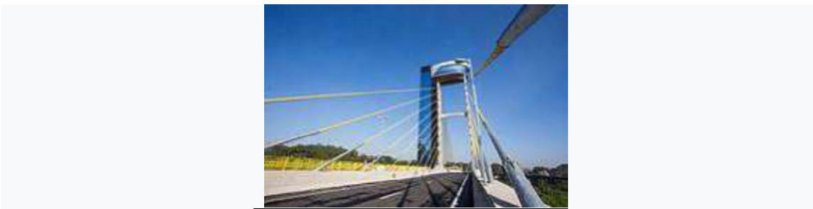
Ponte estaiada com mirante
