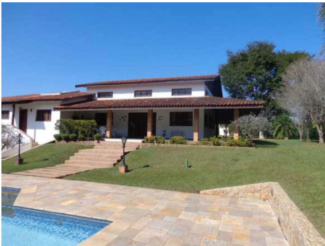
Aspectos da parte posterior da casa
