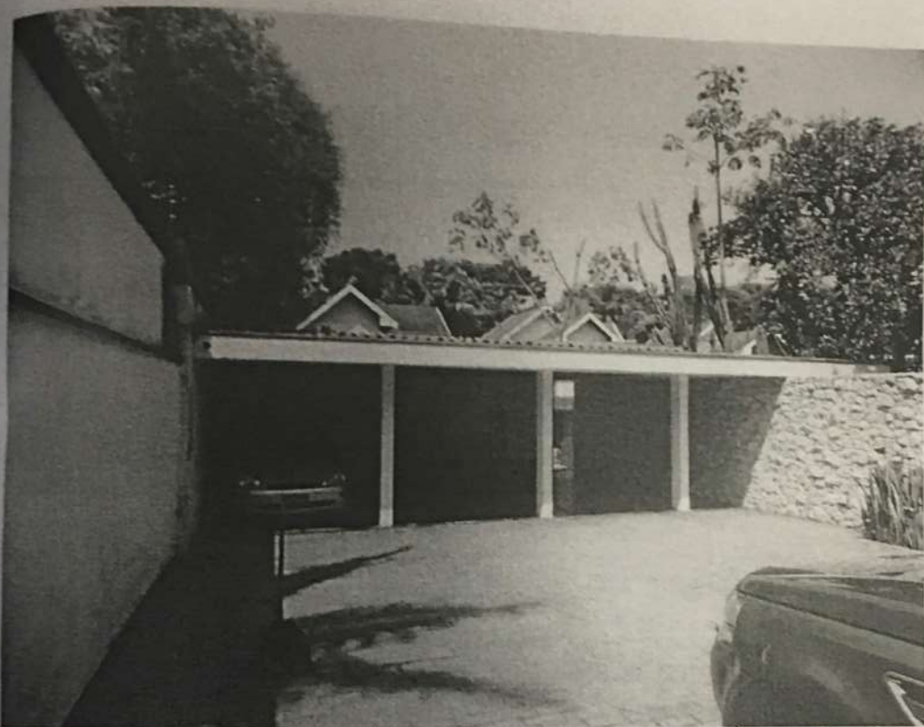
ASPECTOS E CARACTERISTICAS PARCIAIS DAS TRÊS VAGAS DE GARAGEM, NOS FUNDOS DO IMÓVEL AVALIANDO.
