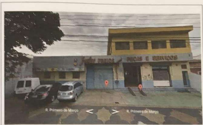
Foto 1 – Fachada do imóvel à Rua Primeiro de Março nº 500.
