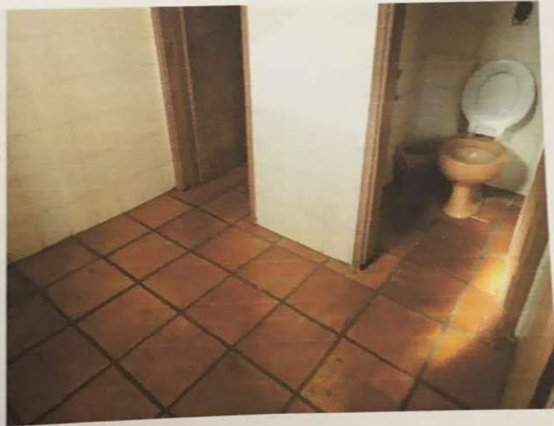
Foto 6 – Área dos sanitários.
