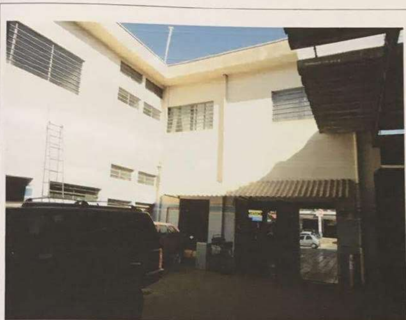
Foto 7 – Parte dos fundos do sobrado comercial.
