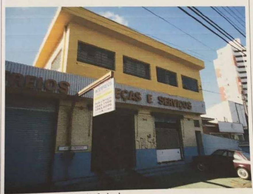
Foto 2 – Outra vista da fachada.
