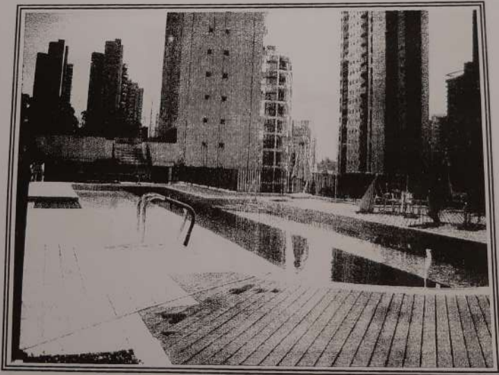
Foto n° 34: Vista da piscina do Condomínio Jardins do Morumbi
