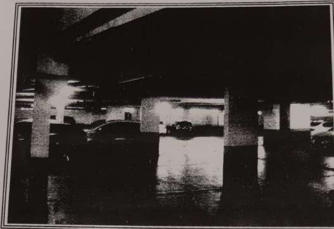
Foto n° 28: Vista geral da garagem no subsolo do Edifício Orquidea
