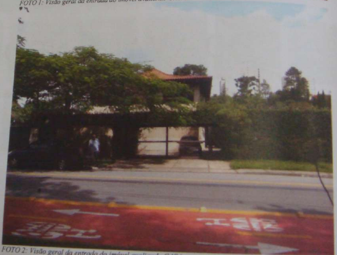
FOTO 1: Visão geral da entrada do imóvel avaliando CASA
