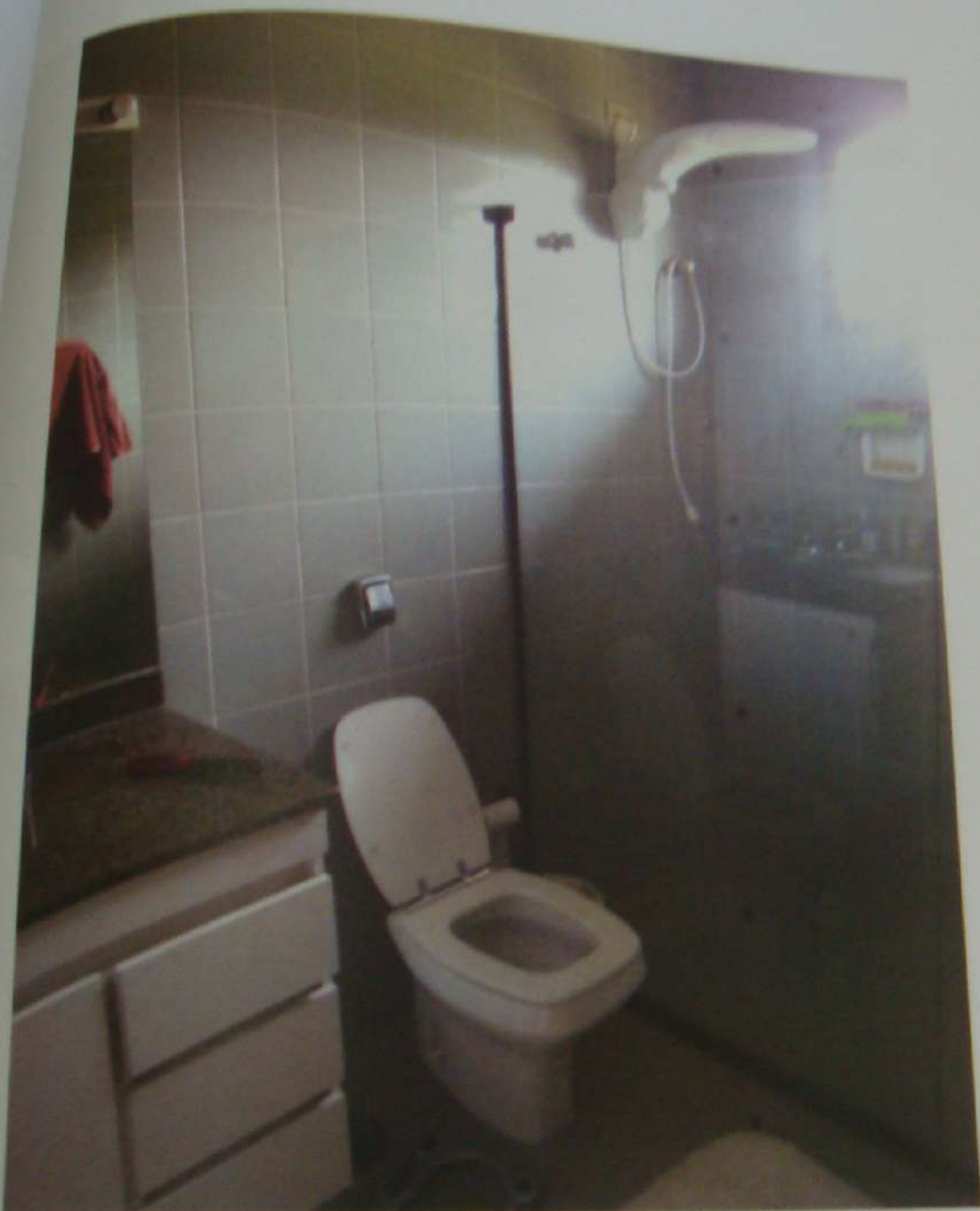
FOTO 30: Banheiro Masculino - Suíte 3 - Pavimento Superior
