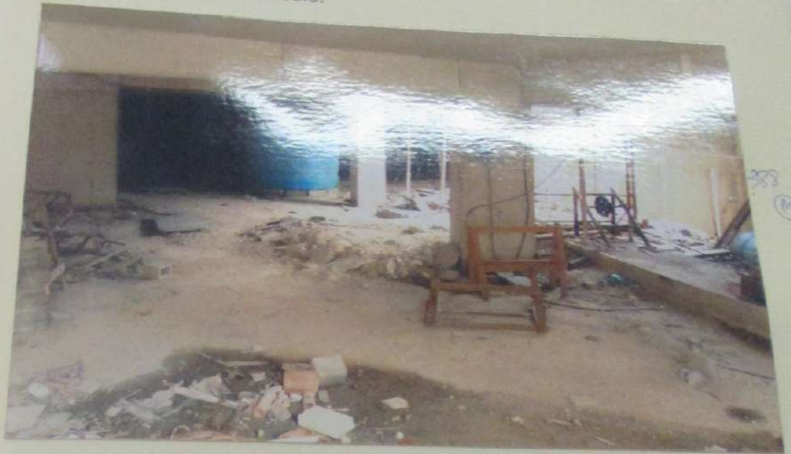
FOTO Nº 2 - Vista do sub-solo.
