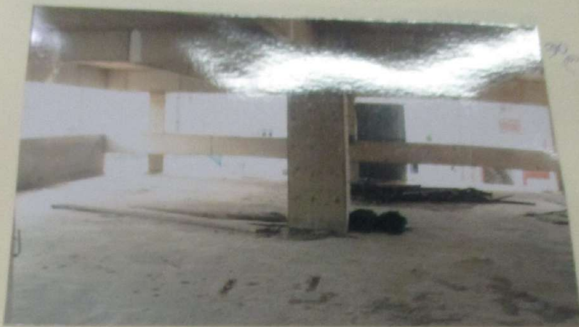
FOTOS Nº 4 e 5 - Vista da garagem no mezanino.
