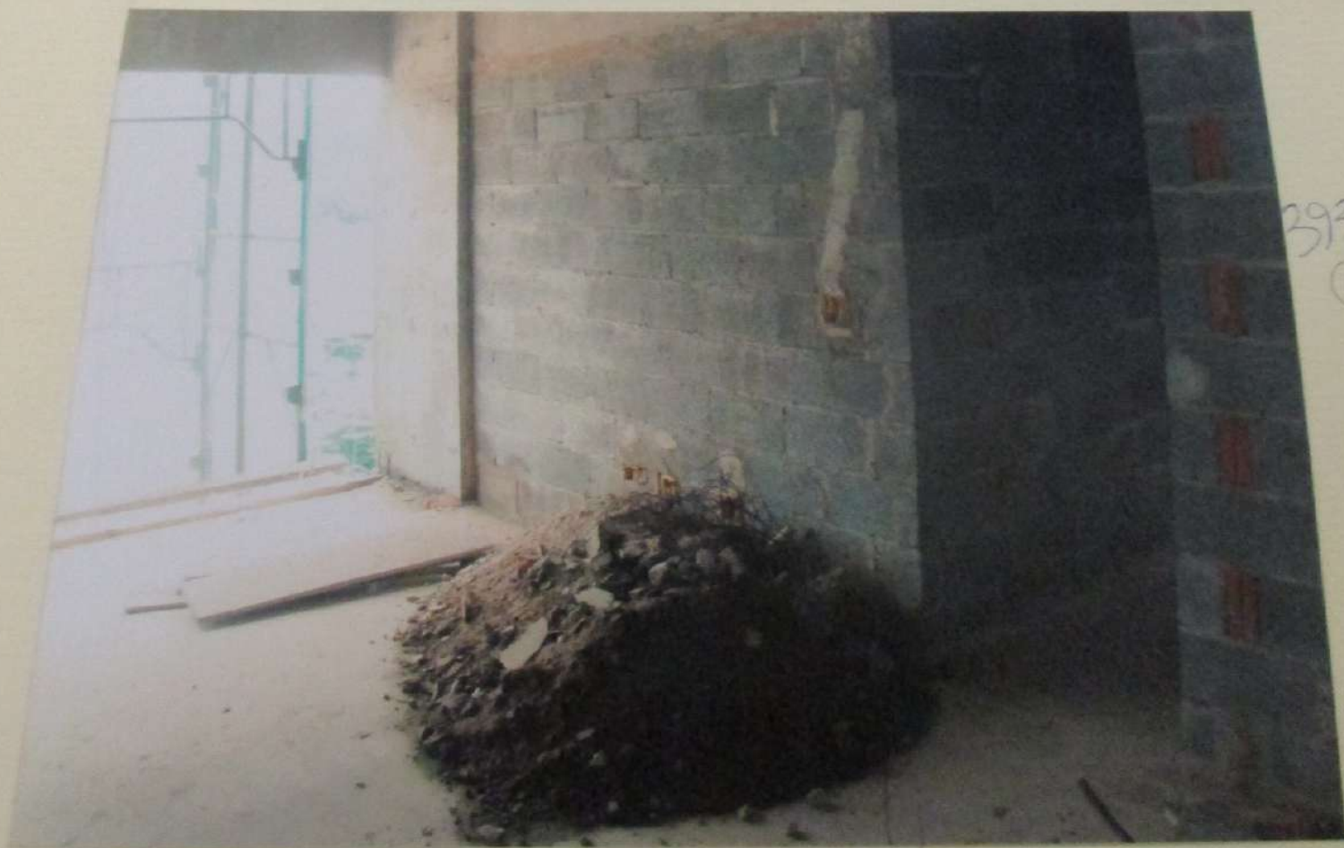
FOTO Nº 7 - Vista da sala da unidade 131.
