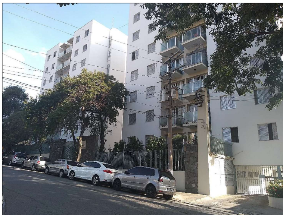
Foto.01- Aspectos da fachada das duas torres do Condomínio Residencial Jardim Guedala de frente para a rua considerada.
