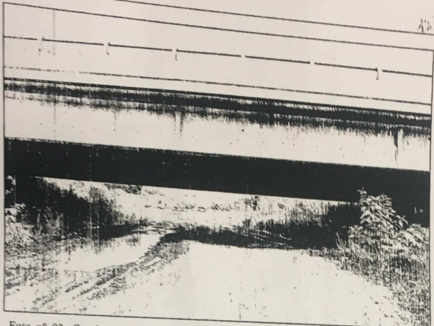
Foto nº 03: Continuação do acesso passando por baixo de outro viaduto da Rodovia Adalberto Pansan, constatando-se a limitação de altura para passagem de veículos e via em terra (avaliando no fundo da foto).
