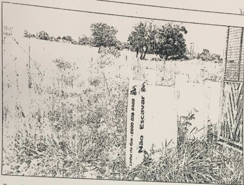
Foto nº 06: Sinalização da servidão de passagem de gasoduto sobre o avaliando (limitação de uso do imóvel do tipo não edificante)
