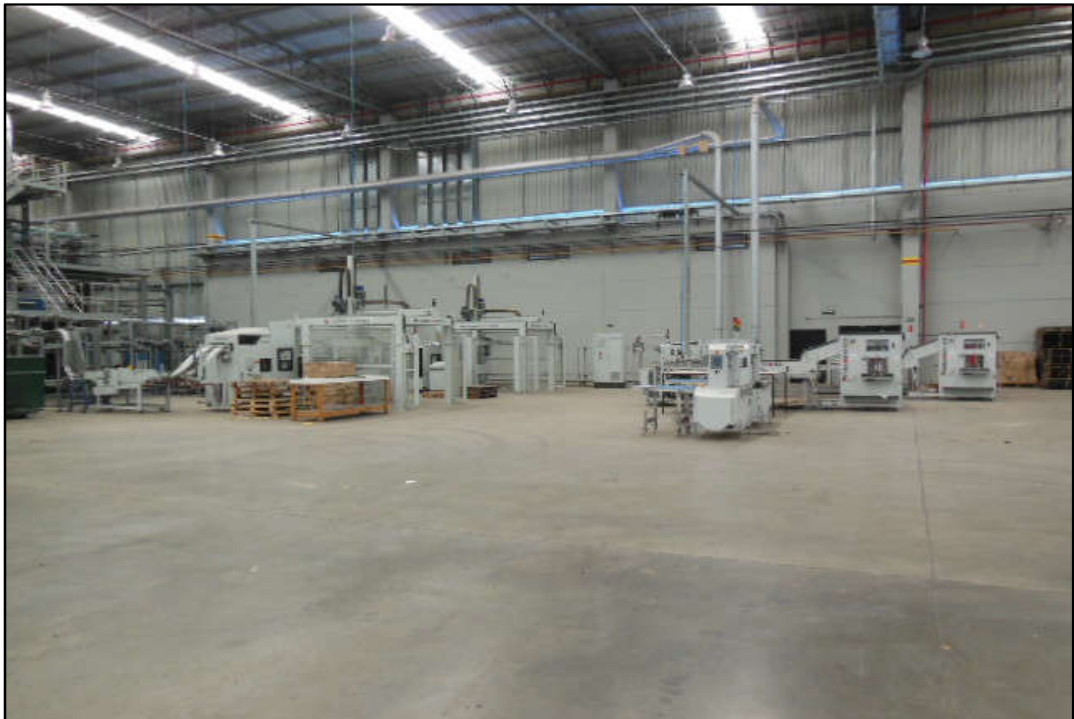
ITEM 1,028 - VISTA DO SISTEMA DE TRANSPORTE E EMBALAGEM MARCA: RIMA-SYSTEM
