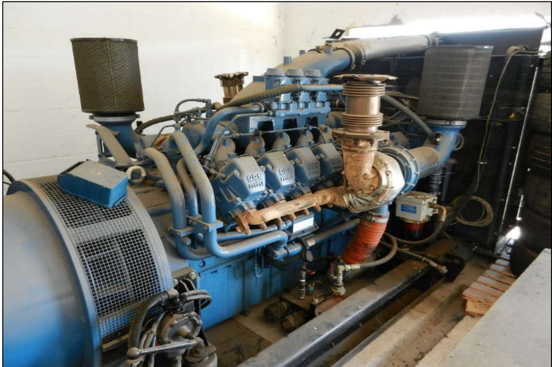
ITEM 1,109 - VISTA DO GRUPO GERADOR A DIESEL MARCA: SDMO TIPO: LSA-50.1 S4-4P CAP: 1.025 KVA 400 V COM MOTOR DIESEL MARCA: MTU
